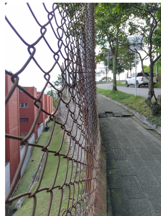
Figura 2. Fotografías del talud monitoreado en el sector Calazanía.
