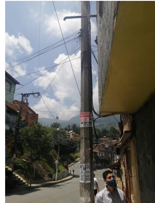
Figura 2. Poste en el que se realizaría la instalación de la cámara de monitoreo.
