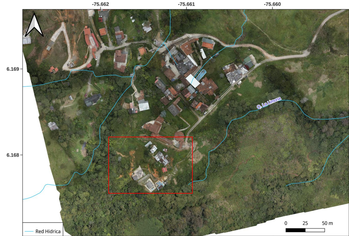
Figura 19. Ortofotografía producto del procesamiento de imágenes de dron, tomadas el día 7 de septiembre.
