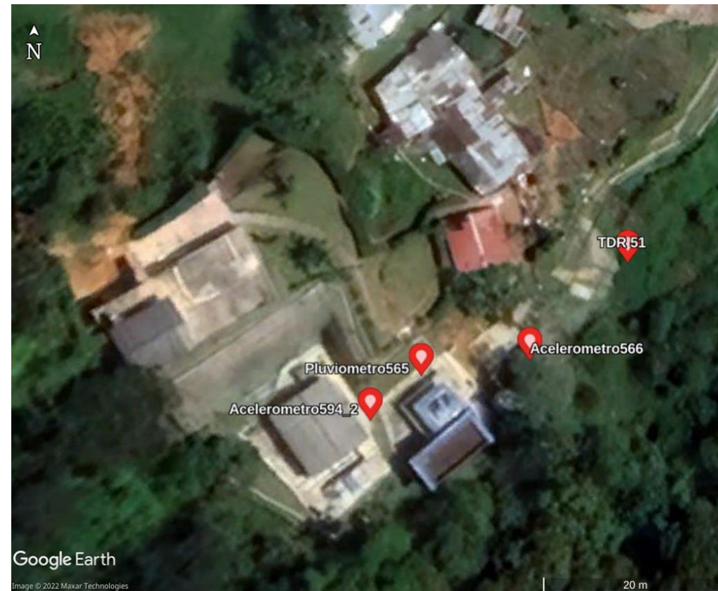
Figura 2. Ubicación de los sensores en la zona afectada.
