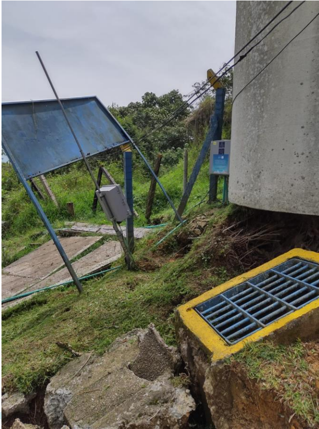
Figura 9. Afectación en la estación instalada en el sitio, donde se observa el estado de la estación principal y la rotura de los cables tanto del equipo TDR como del extensómetro instalado.
