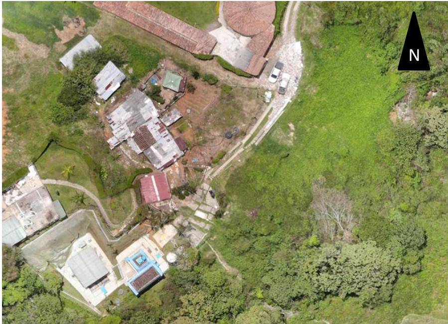
Figura 1. Ortofoto del sitio monitoreado, en la esquina inferior izquierda se encuentra la planta de acueducto de la vereda San José
