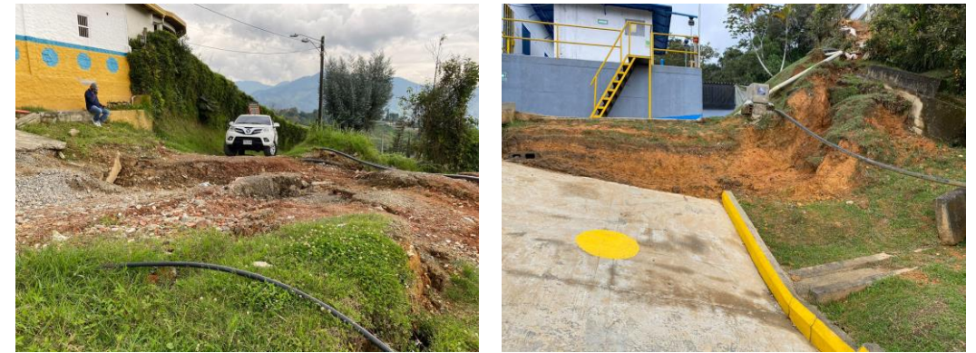
Figura 8. Deformaciones del terreno durante la visita realizada el pasado 9 de marzo.
