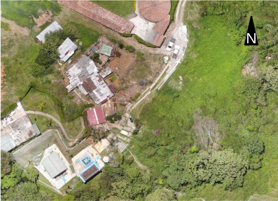
Figura 1. Ortofoto del sitio monitoreado, en la esquina inferior izquierda se encuentra la planta de acueducto de la vereda San José
