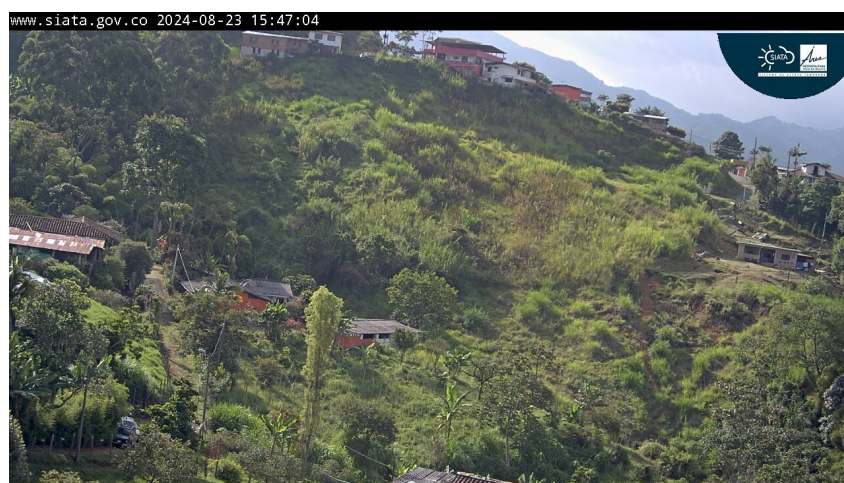
Figura 3: Fotografía de la cámara de monitoreo registrada el 23 de agosto de 2024. Se observa la recuperación de la cobertura vegetal en el cuerpo del deslizamiento.
