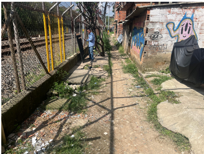
Figura 3: Localización del punto propuesto de monitoreo ubicado en el cerramiento que divide la Línea A del metro con las viviendas del barrio La Paralela.
