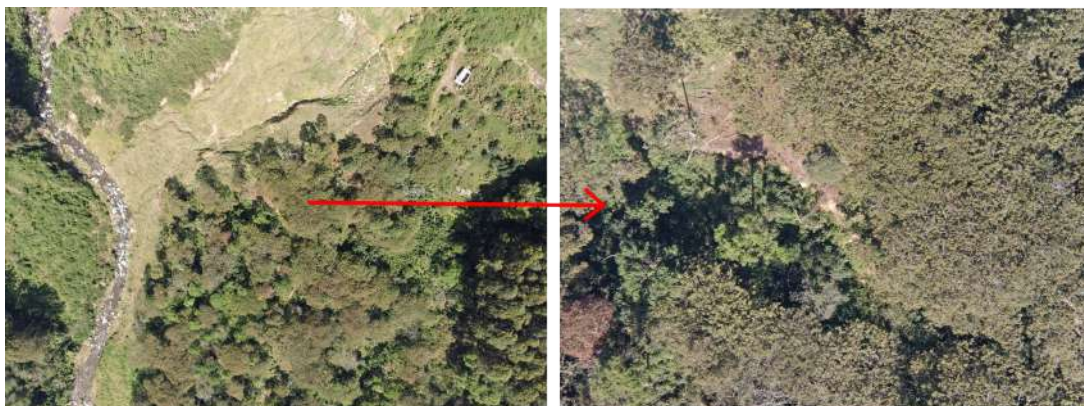
Figura 8: Imagen izquierda ubicación de grietas en la parte baja del flanco oriental. Imagen derecha, fotografía de detalle de esta zona.
