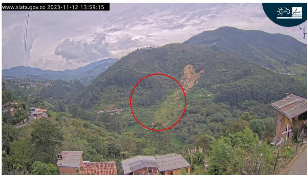
Figura 5: Fotografías de la cámara de monitoreo de agosto y noviembre de 2023. El círculo rojo indica la zona donde se presentó la tala de árboles en el flanco occidental.
