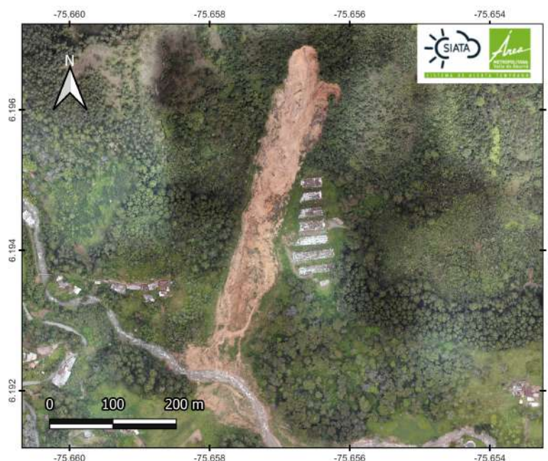
Figura 11: Ortofoto realizada al sitio el 26 de diciembre de 2022. Se observa la recuperación de la cobertura vegetal y la ampliación del canal obstruido de la quebrada Doña María.
