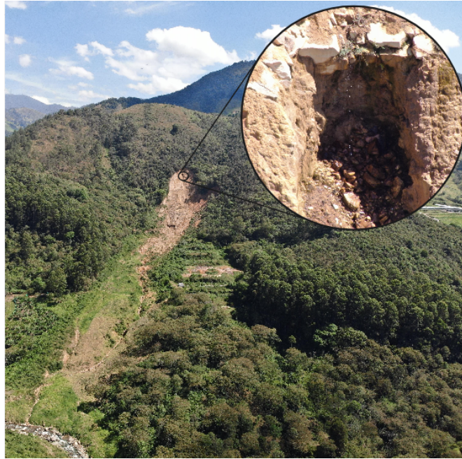
Figura 18: Foto panorámica realizada el 30 de agosto del 2023, en el círculo se muestra una foto ampliada del afloramiento de agua en la parte alta de la ladera.
