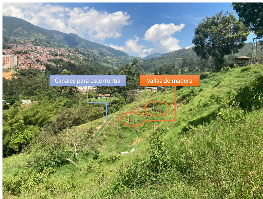
Figura 4: Obras de manejo de aguas y contención en Finca La Montana.
