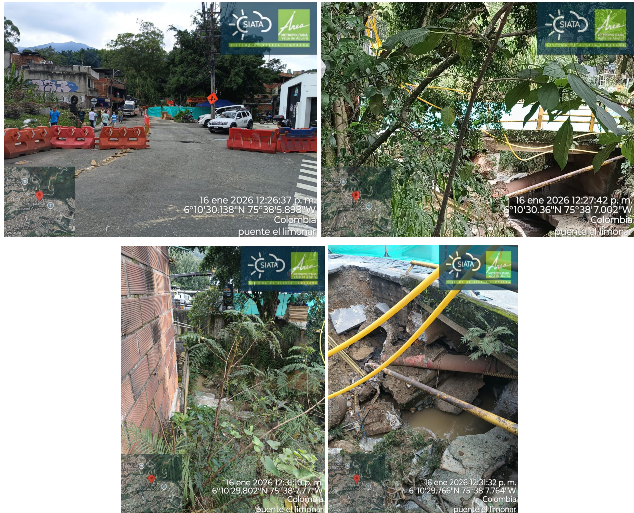
Imagen 1. Vistas generales de los posibles puntos de ubicación del radar interferométrico para el monitoreo, así como de las limitaciones técnicas y operativas asociadas.
