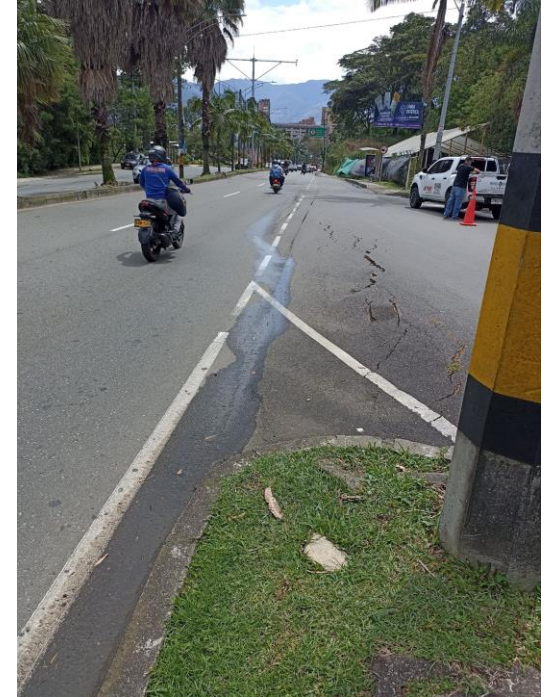
Figura 4. Agrietamiento y hundimiento en la calzada en dirección Rionegro - Medellín.
