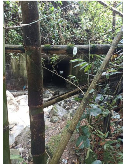
Figura 7. Estructura del box culvert. Vista antes del puente vehicular.
