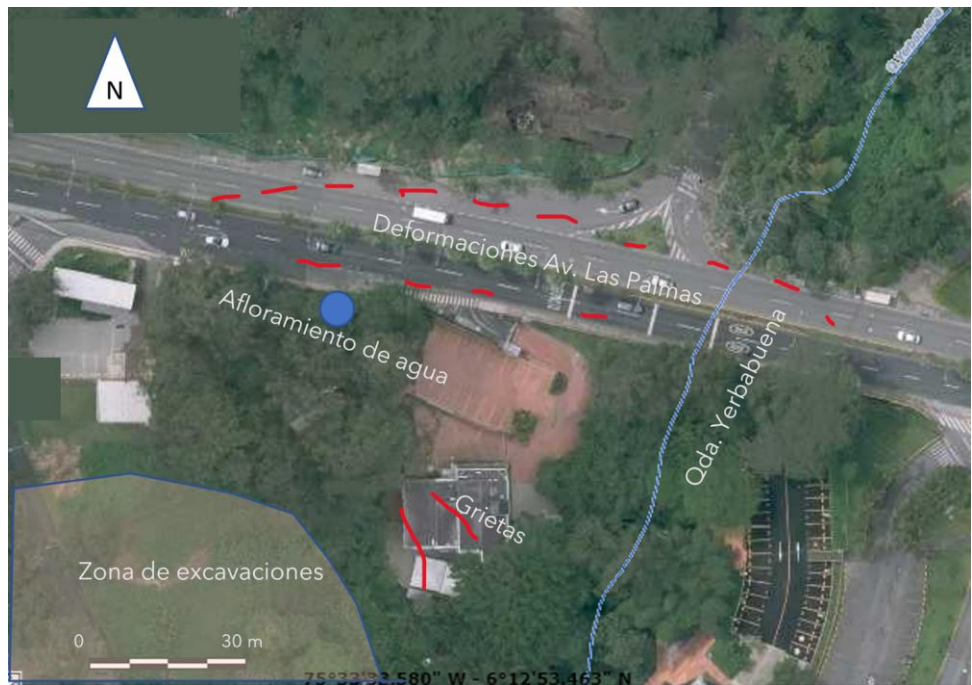
Figura 1. Afectaciones en el tramo de la vía Las Palmas, sector Hato Viejo a la altura del puente de la quebrada Yerbabuena.
