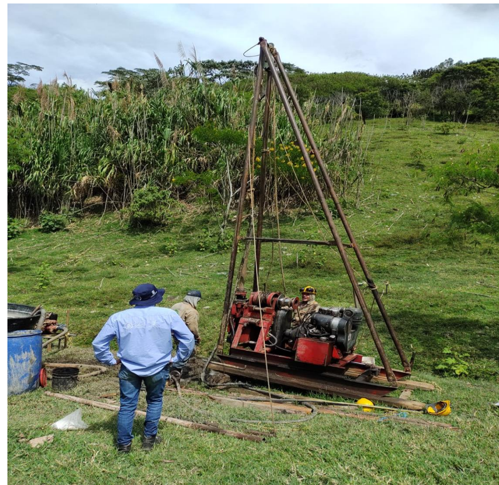
Figura 1. Registro fotográfico del proceso de perforación para la instalación de los inclinómetros en el sitio.
