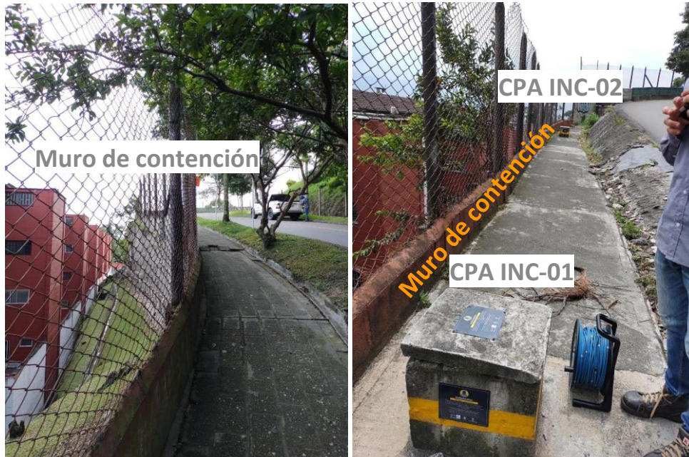
Figura 2. Fotografías del sitio monitoreado: talud con obra de contención monitoreado, cota inferior unidad residencial Calasania 1, cota superior vía vehicular (izquierda); ubicación de los inclinómetros instalados en el lugar, sobre el muro de contención (derecha).
