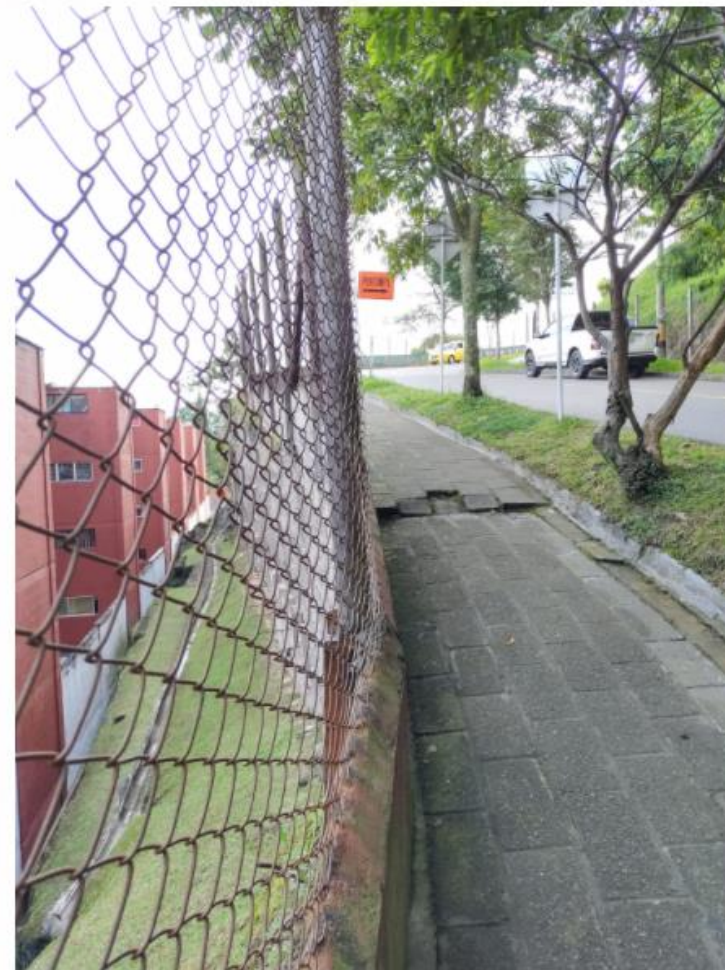
Figura 4. Estado actual de la Estructura de contención.
