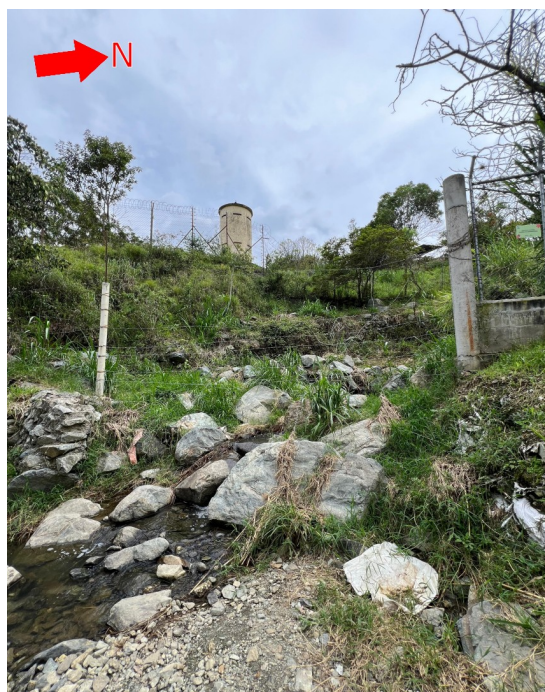
Figura 2: Fotografía registrada en visita realizada el 6 de junio de 2024 donde se observa la intersección de la Quebradada Malpaso, con la vía de acceso al sector El Chispero. Se observan bloques de roca sobre el lecho de la quebrada, producto de la dinámica activa de las vertientes de la cuenca.
