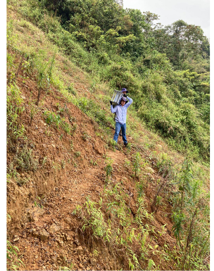
Figura 7c. Estado actual del camino hacia Cámara 1.
