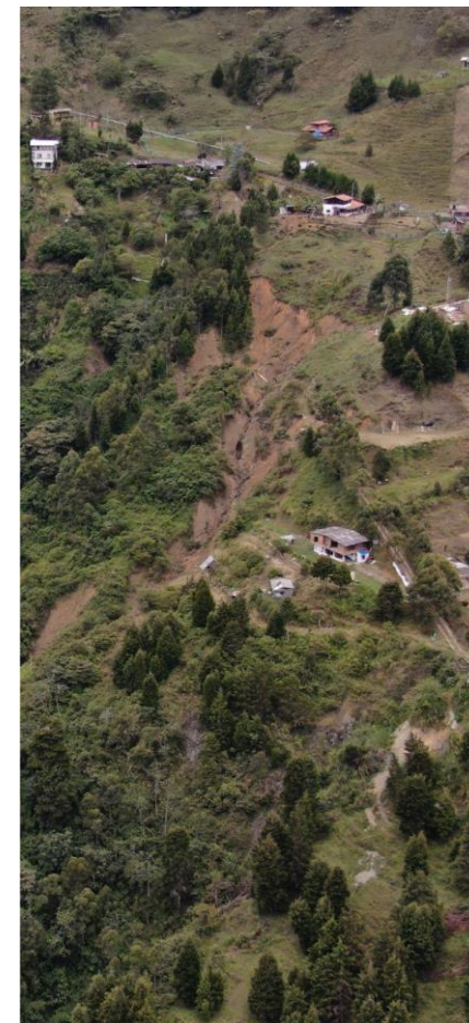
Figura 11. Punto crítico sobre la parte alta de la cuenca de la quebrada La Raya. Fotografía tomada el día 19 de septiembre de 2022.
