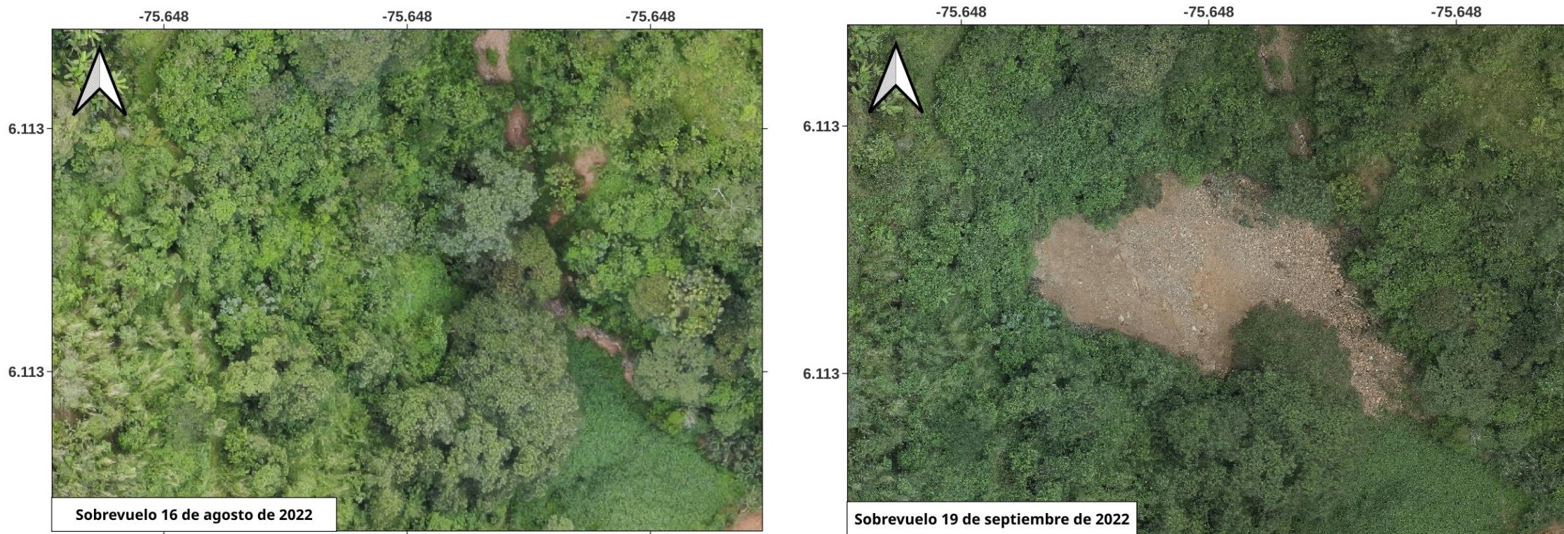
Figura 19. Afectaciones en el acceso al acueducto de la vereda San José
