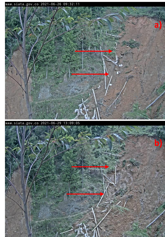
Figura 2. Captura de la cámara de monitoreo, dirigida hacia una de las cárcavas existentes. Este punto es el mostrado en la fig.1; se evidencia el colapso, el cual continúa luego de 3 días de reconexión.
