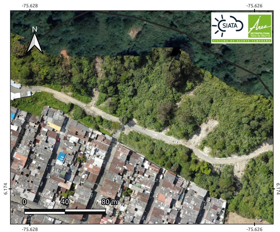
Figura 12: Ortofoto realizada al sitio el 12 de agosto de 2022. Se observa parcialmente la ladera norte del barrio Villalía y los procesos morfodinámicos materializados en junio de 2022
