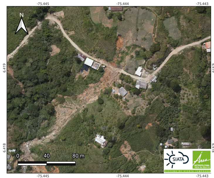
Figura 4: Flujos de lodos y/o escombros, se observan afectaciones en edificaciones residenciales, en la vía vehicular y en parcela agrícola.
