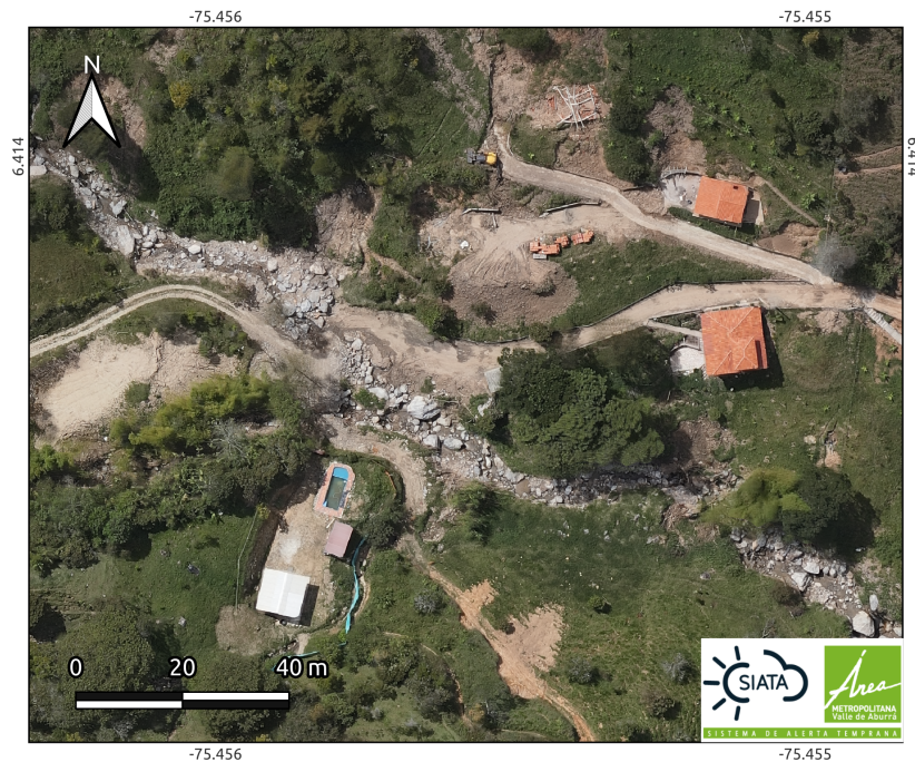
Figura 6: Afectaciones asociadas al flujo torrencial en la parte alta de la microcuenca de la quebrada Del Protrerito, donde se observa la afectación total a la vía vehicular.
