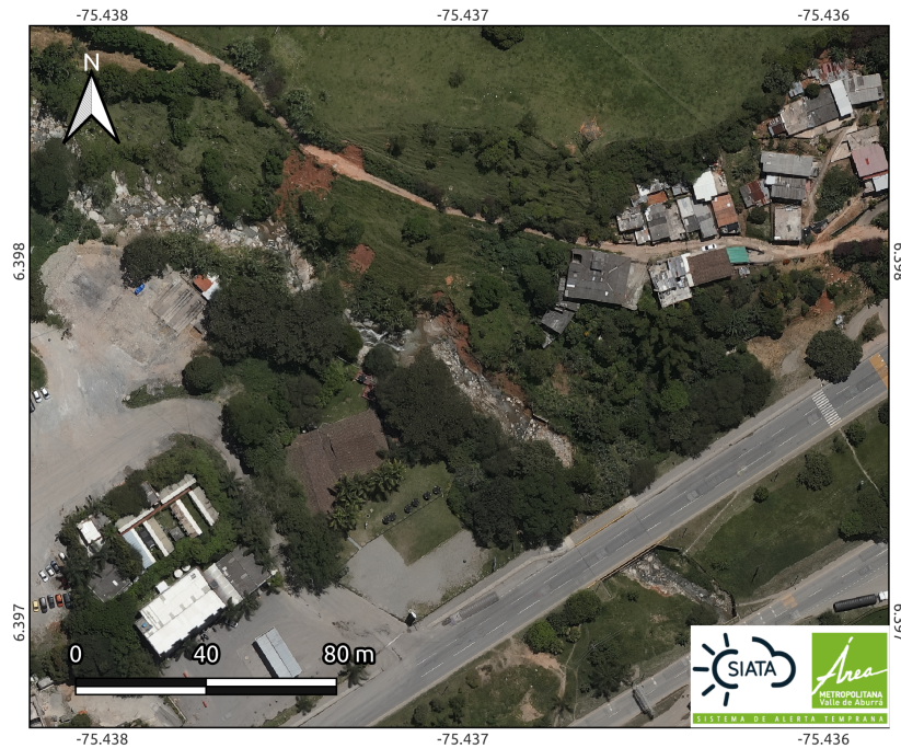
Figura 7: Parte baja de la quebrada La Correa a la altura de la Autopista Norte. Nótese la extensión de los procesos erosivos y de depositación de los flujos torrenciales en este sector.
