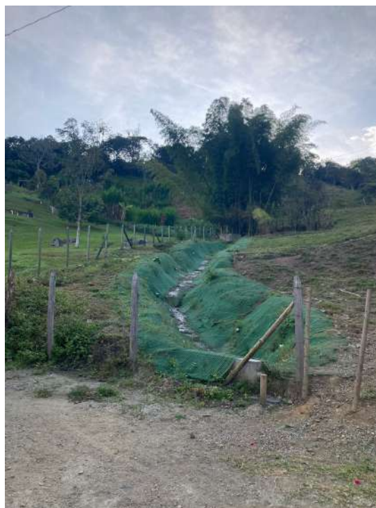
Figura 7: Cauce con geotextiles.
