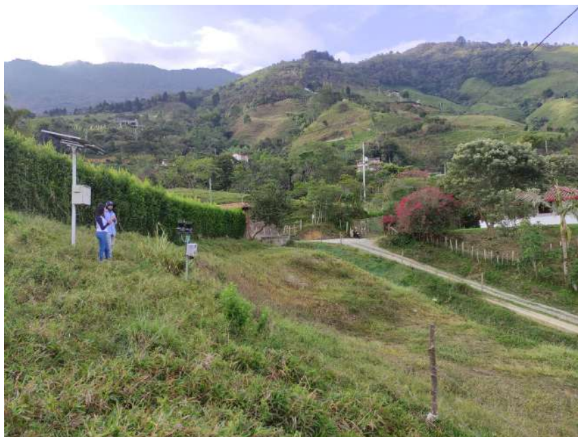
Figura 6: Estado actual de la parte alta del deslizamiento, donde se encuentran ubicados el extensómetro y pluviómetro activos.
