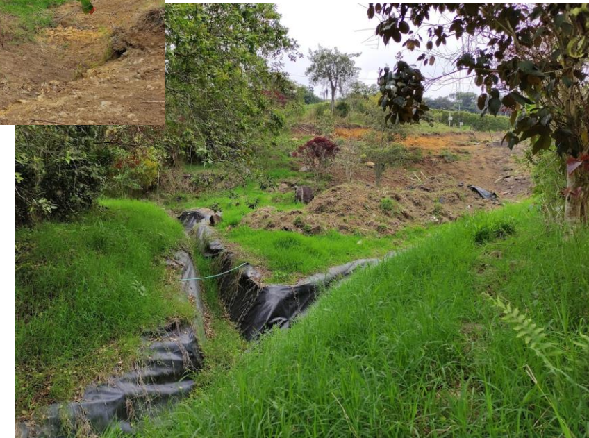
Figura 2. Estado actual de la zona de monitoreo.
