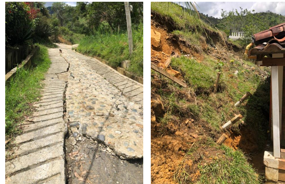
Figura 4. La imagen de la izquierda muestra evidencias de deformación en la vía de ingreso a las fincas afectadas. La imagen de la derecha muestra el avance del deslizamiento hacia la parte trasera de la casa de la finca del señor Sergio Acevedo.
