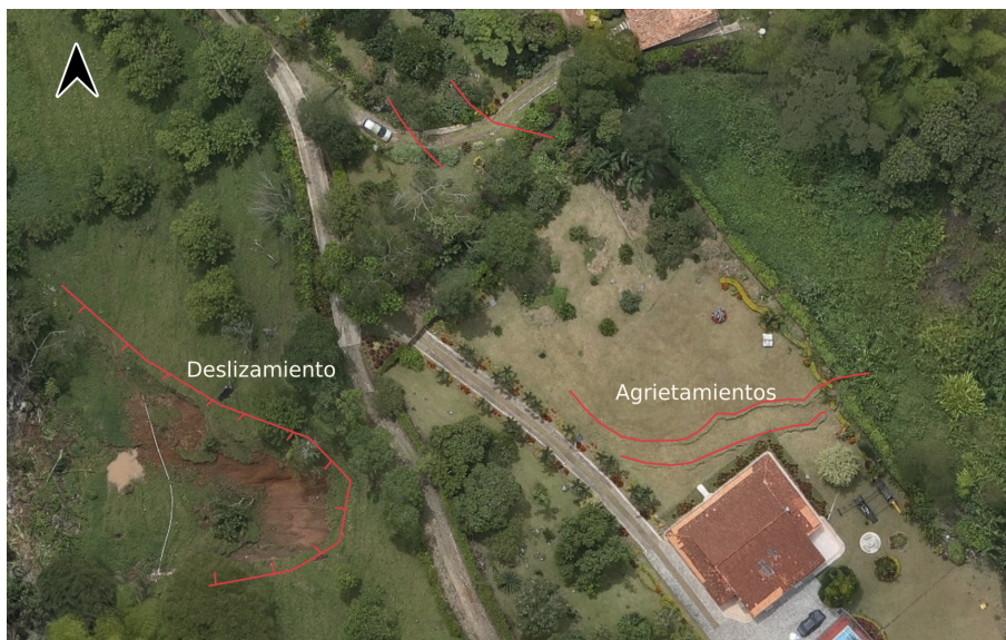
Figura 8. Deslizamiento y agrietamientos evidenciados en ortofotografía de drones en el sector La Amelia.
