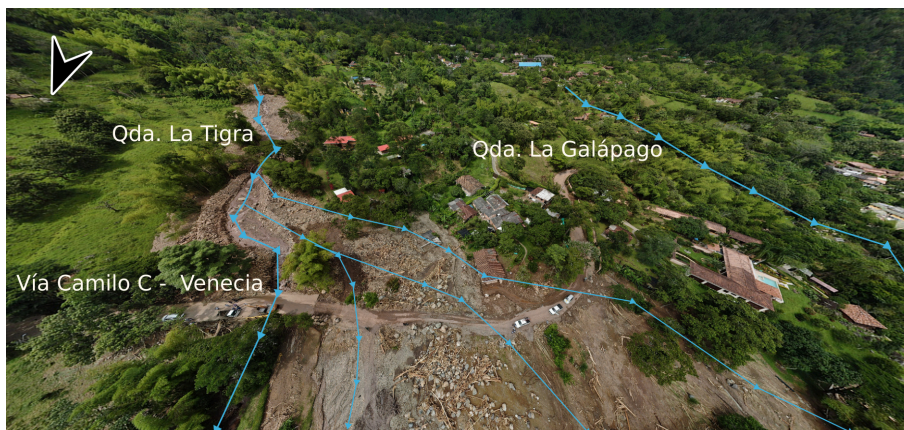
Figura 7. Fotografía de dron de la zona de abanico torrencial y desbordamiento de la quebrada La Tigra a la altura del puente Santa Ana.
