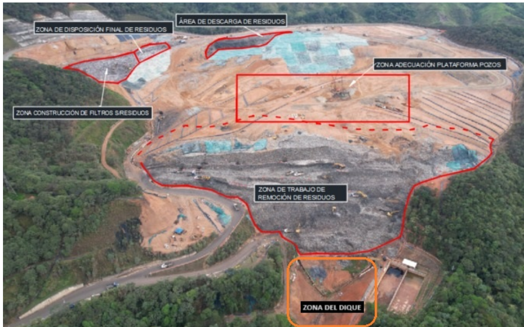
Figura 1: Zona de disposición de residuos en el Vaso Altair del relleno sanitario La Pradera.
