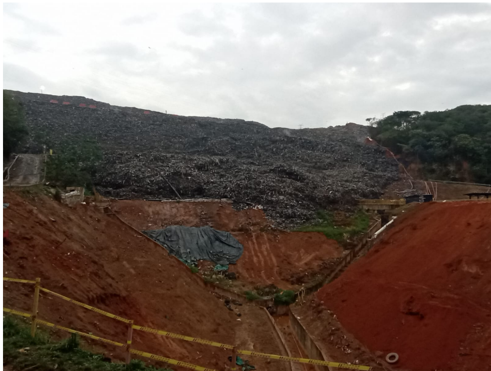
Figura 2: Sector del dique en el Vaso Altair del relleno sanitario La Pradera.
