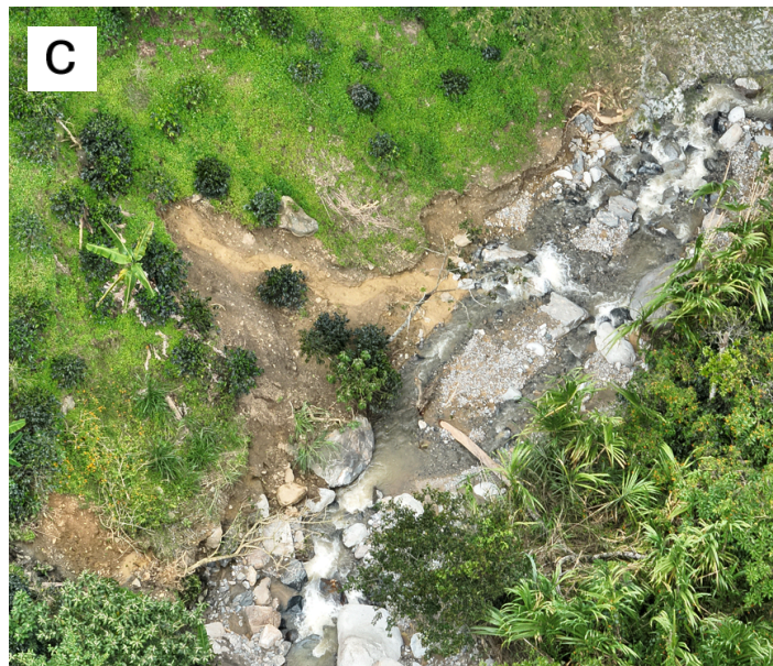
Figura 2. Deslizamientos sobre el cauce.
