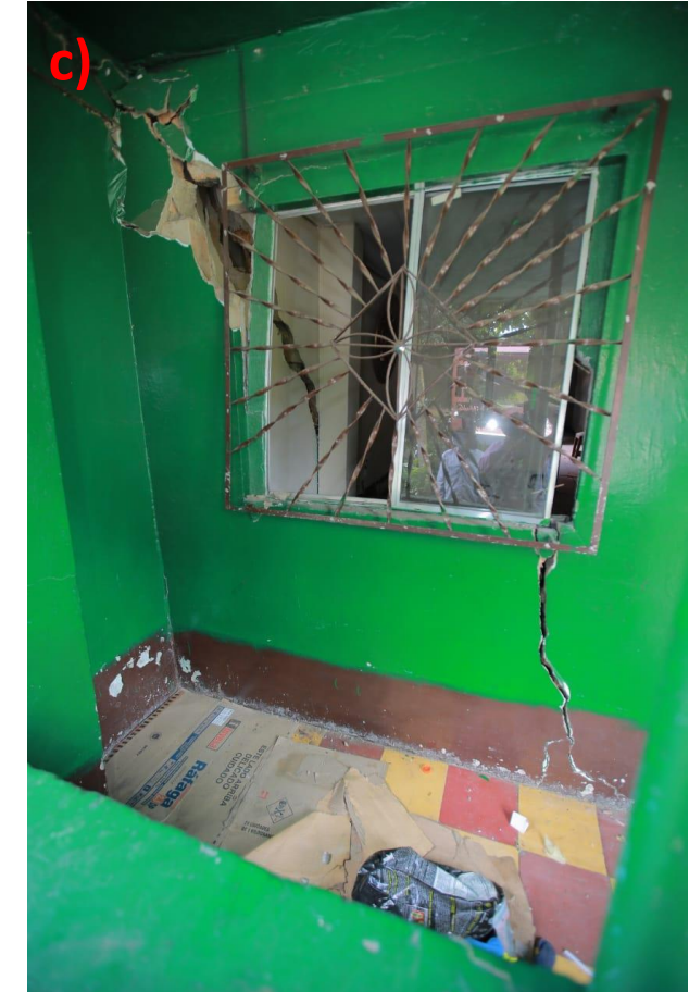
Las figuras a y b muestran viviendas ubicadas sobre la margen derecha de la autopista norte donde se evidencian agrietamientos en las estructuras. La figura c corresponde al deterioro observado en una vivienda ubicada detrás de la estación de gasolina.
