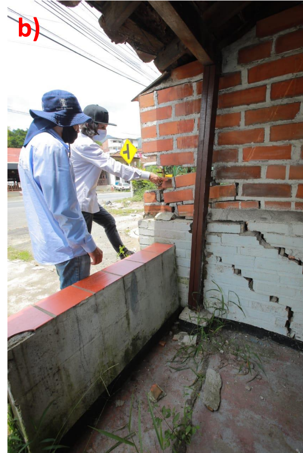
Las figuras a y b muestran viviendas ubicadas sobre la margen derecha de la autopista norte donde se evidencian agrietamientos en las estructuras. La figura c corresponde al deterioro observado en una vivienda ubicada detrás de la estación de gasolina.
