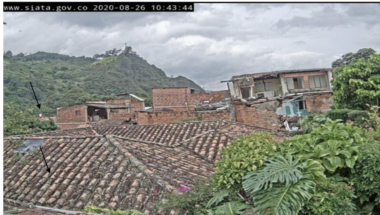
Figura 3. Sectores dónde se ha identificado la presencia de personas en las infraestructura en riesgo de colapso en el sector.
