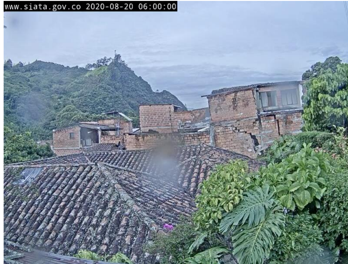
Video 1. Seguimiento semanal casas en riesgo de colapso sector Ancón 2 (Copacabana)
