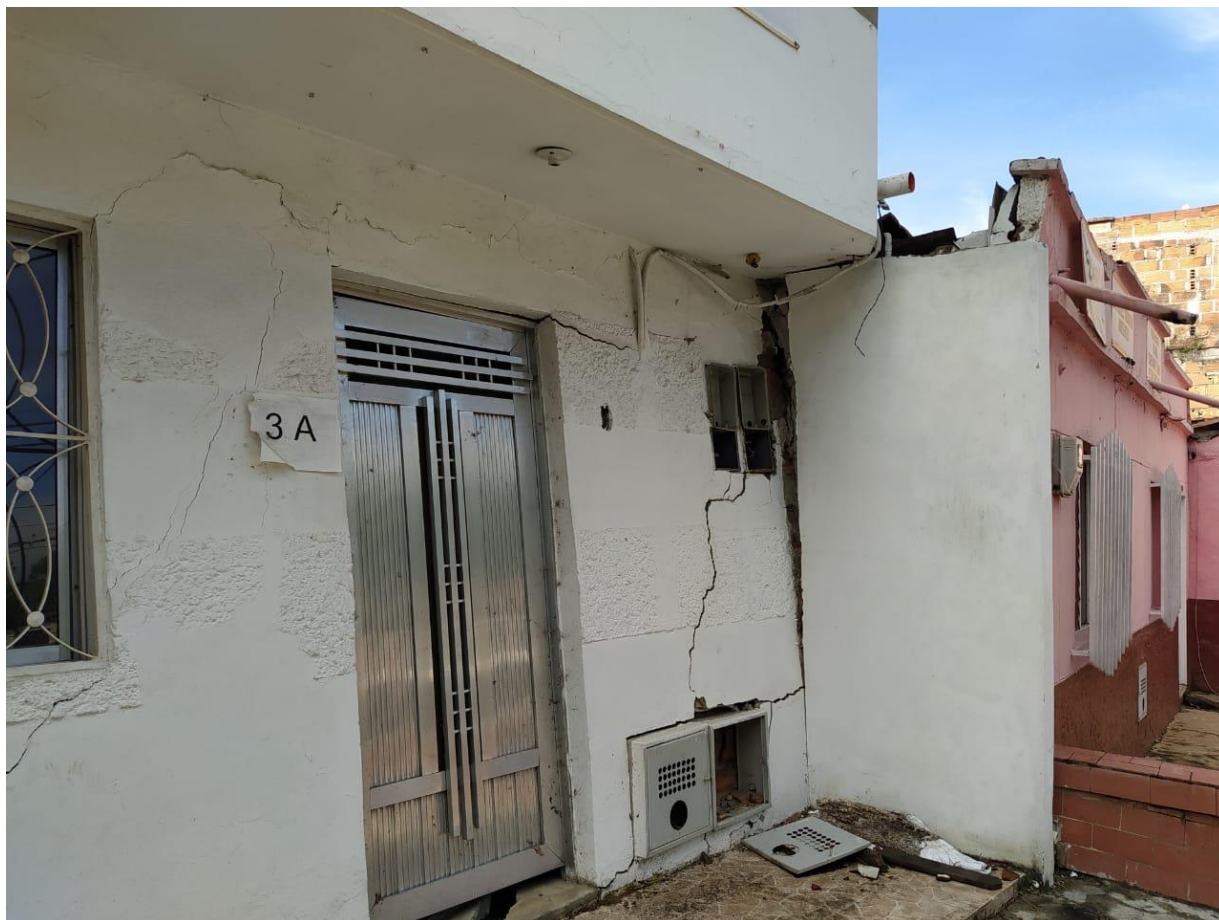
Figura 2. Estado de la inclinación de las viviendas ubicadas hacia la doblecalzada.
