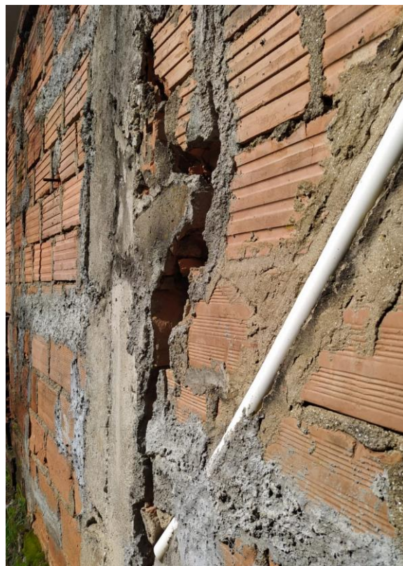
Figura 1. Estado de las viviendas hacia la vía en sentido Norte con riesgo de colapso.
