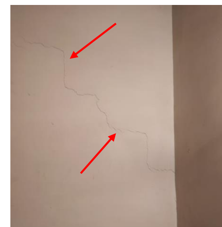
Figura 3. Afectaciones en las viviendas más cercanas al río donde los habitantes reportan el avance de grietas en los últimos meses, tanto en muros como en la acera.
