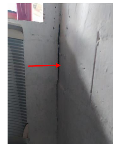
Figura 3. Afectaciones en las viviendas más cercanas al río donde los habitantes reportan el avance de grietas en los últimos meses, tanto en muros como en la acera.
