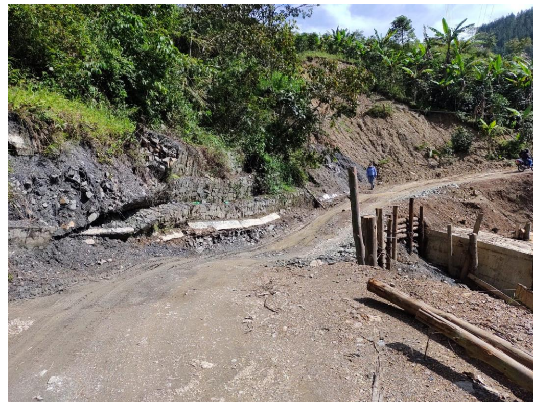
Figura 1. Tramo de vía veredal afectado por procesos de remoción de masa.
