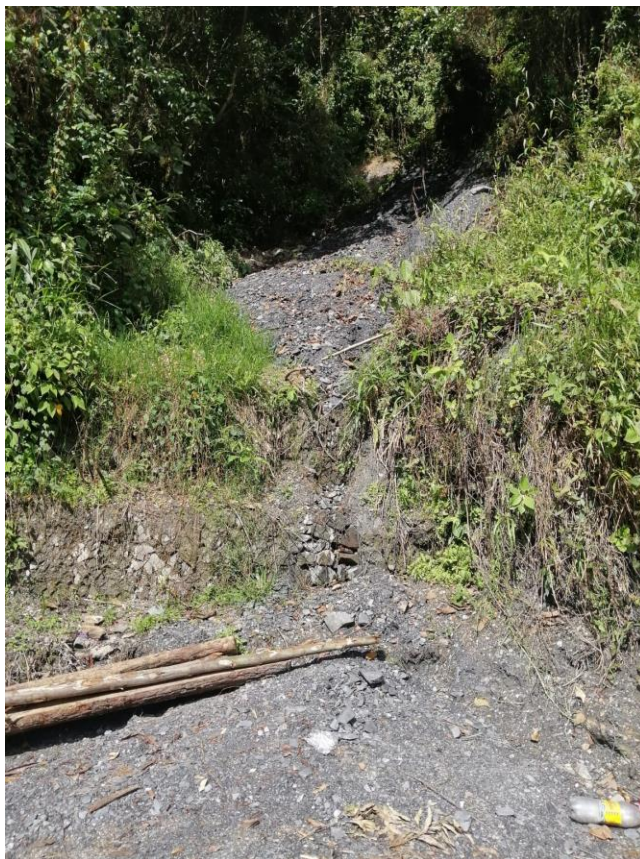
Figura 4. Cono de detritos depositado sobre vía vehicular.
