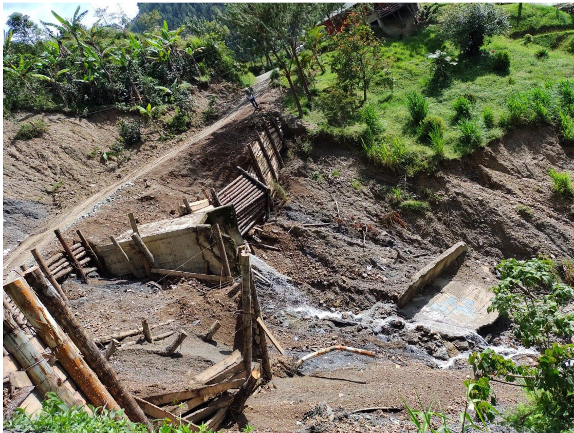
Figura 2. Deslizamiento con afectaciones a vía veredal y estructura hidraulica tipo box culvert en quebrada La Rafaela.
