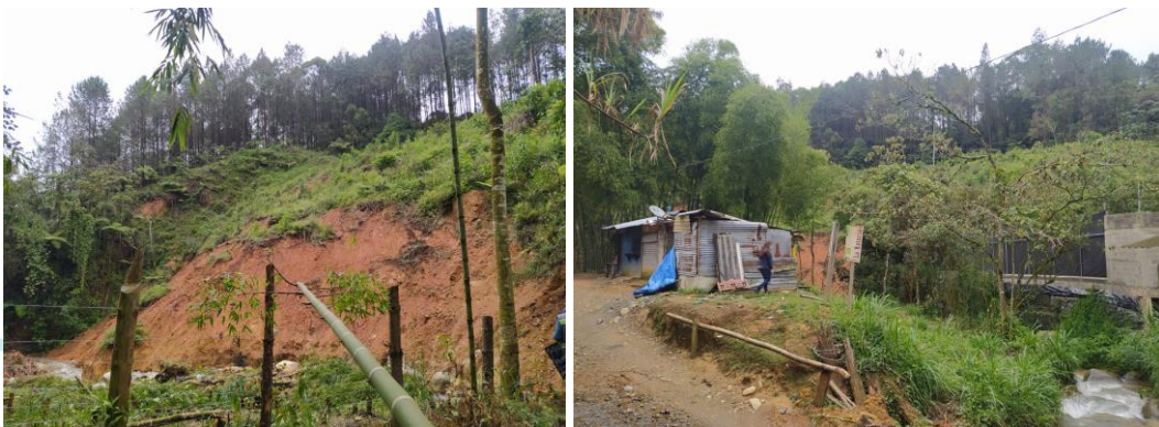
Figura 1. Estado del deslizamiento y la quebrada La Valeria parte alta durante la visita realizada el 26 de agosto por parte del personal de AMVA-SIATA.
