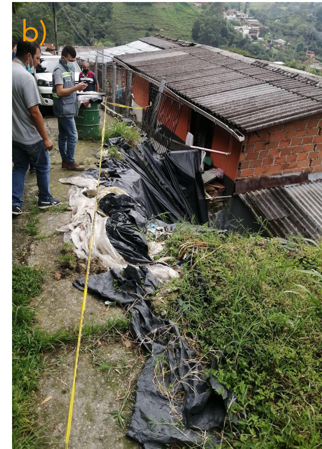
Figura 1. a) Vía veredal con daño por erosión. Se observa un poste inclinado por el avance del deterioro en la zona. b) Parte alta del talud afectado, el cual se encuentra cubierto con plásticos.
