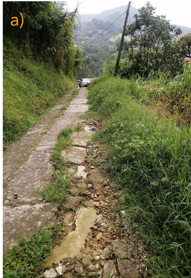
Figura 1. a) Vía veredal con daño por erosión. Se observa un poste inclinado por el avance del deterioro en la zona. b) Parte alta del talud afectado, el cual se encuentra cubierto con plásticos.
