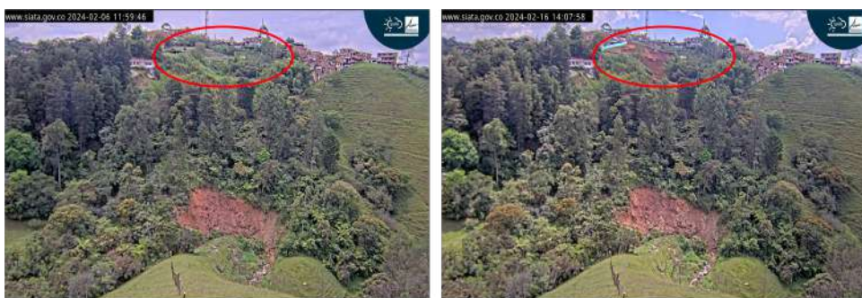
Figura 4: Estado actual del sector andalusia en la parte alta del sector.
