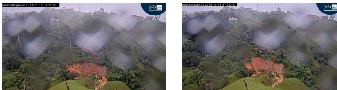
Figura 8: Desplazamiento y caída de suelo y vegetación registrado entre las 7:20 y 7:30 el día 15 de noviembre.
