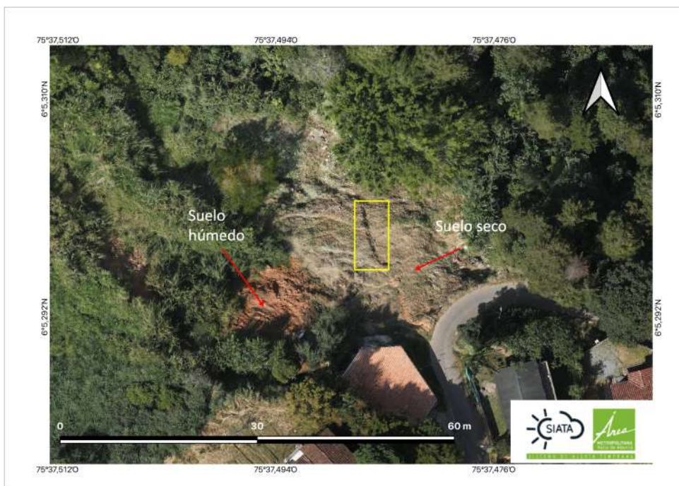
Figura 3: Sobrevuelo realizado el 24 de enero de 2024 en el sector de Andalusia, municipio de Caldas. Parte alta del deslizamiento
