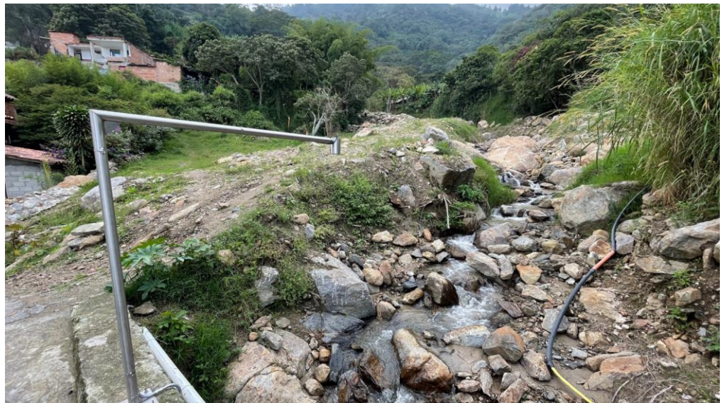
Figura 2. Sensor de nivel y estado de la quebrada la Ortega durante la visita realizada el 10 de noviembre por parte del personal de AMVA-SIATA.
