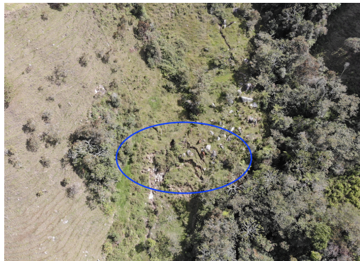
(c) Grietas en el terreno identificadas mediante sobrevuelo, vía Matasanos-Barbosa.
