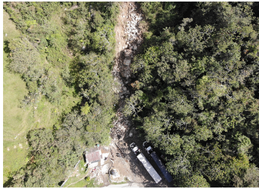
(a) Desprendimiento de material en zona alejada a lavadero de vehículos de carga pesada, vía Matasanos-Barbosa.
