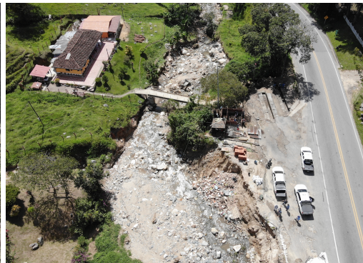
(d) Pérdida parcial de banca por desbordamiento de la quebrada Cestillal en evento de precipitación.
