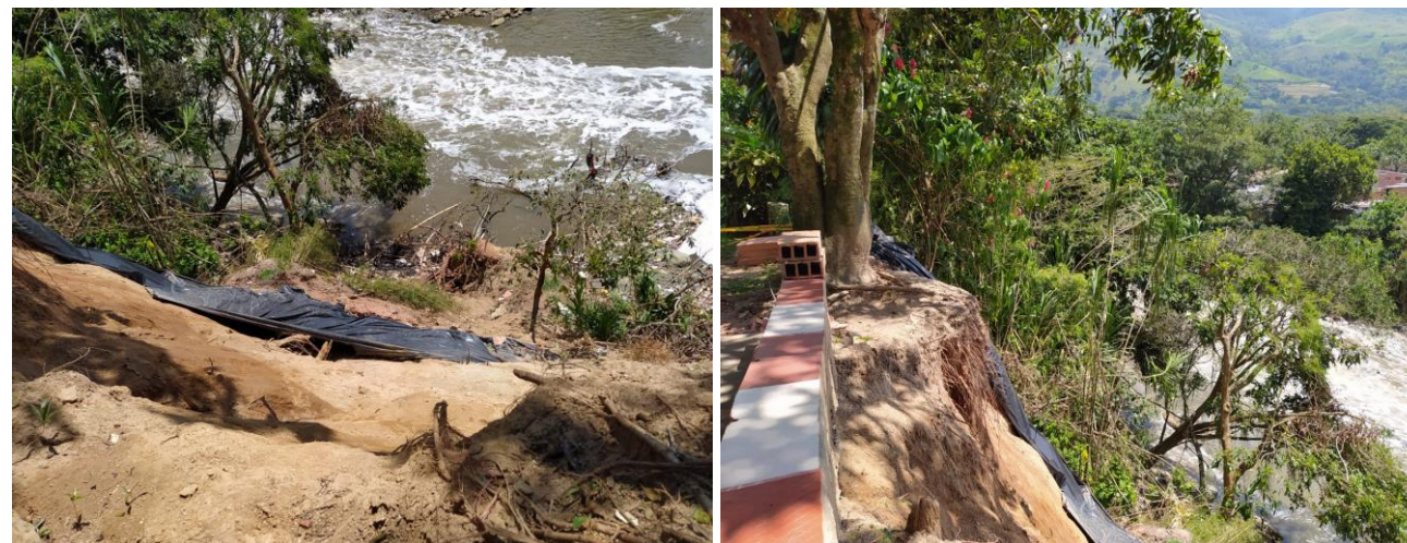
Figura 2. Avance del proceso de remoción en la margen derecha del río Aburrá dónde se puede observar la cercanía con las viviendas del sector.
