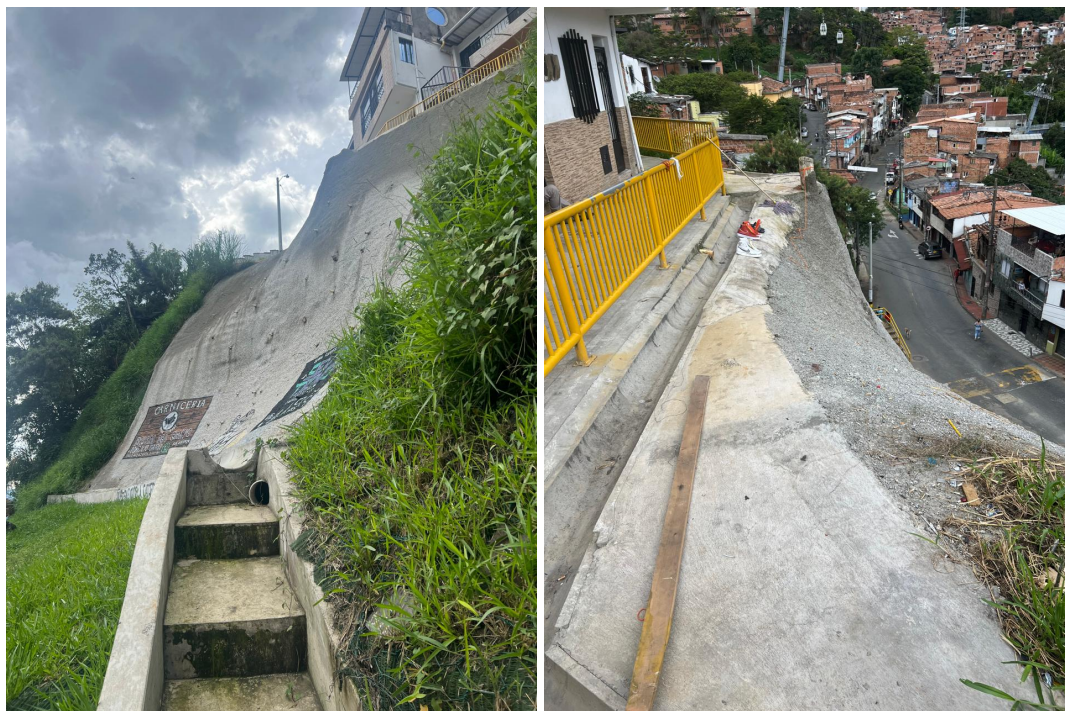
Figura 10: Fotografías tomadas en el sitio el 13 de junio de 2024. Se evidencian obras hidráulicas sin obstrucciones; no se observaron agrietamientos en la obra de estabilización al momento de la visita.
