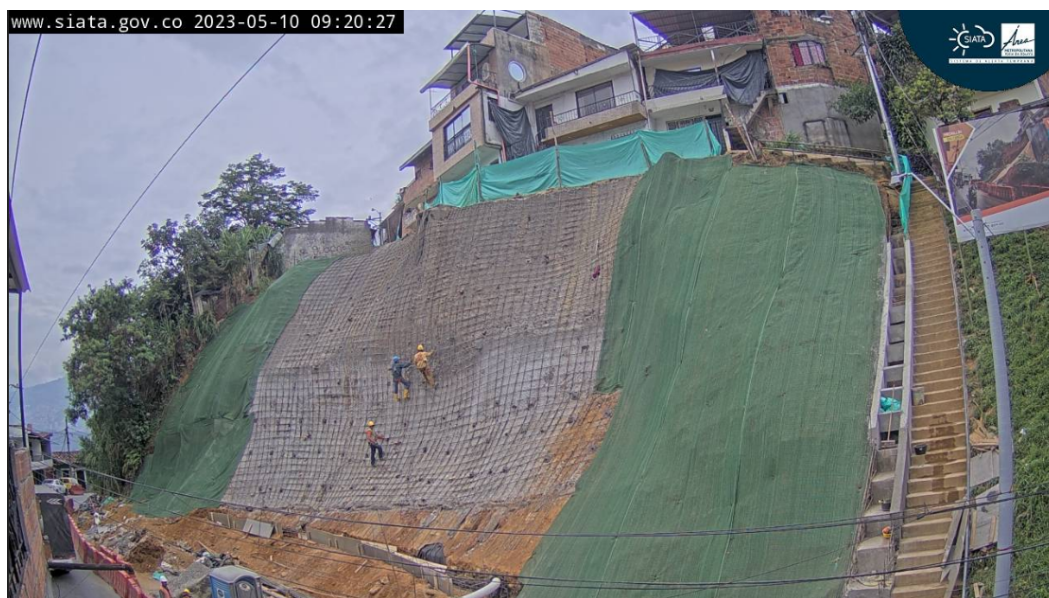
Figura 7: Fotografía registrada por la cámara de monitoreo el 10 de mayo de 2023. Se observan obras de estabilización en el talud monitoreado, con revestimiento de concreto lanzado, mallas, drenes horizontales y geomembrana; además, se evidencia una ronda de coronación en concreto, escalonada en los flancos para redirigir el agua desde la parte alta del talud intervenido.
