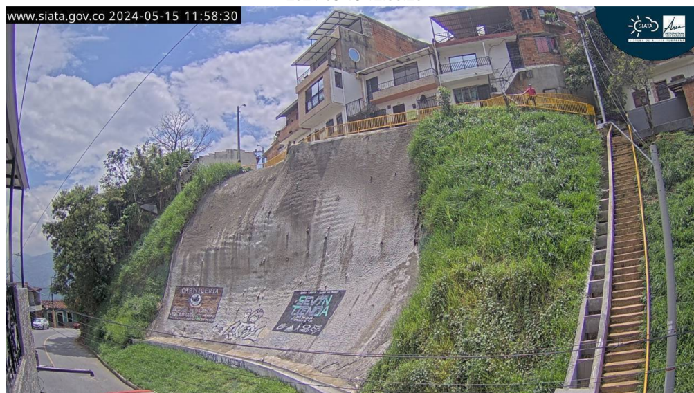
Figura 9: Fotografía registrada por la cámara de monitoreo el 15 de mayo de 2024. Se evidencia crecimiento de la cobertura vegetal en los costados del talud intervenido, sin evidencias de algún estado de reactivación.
