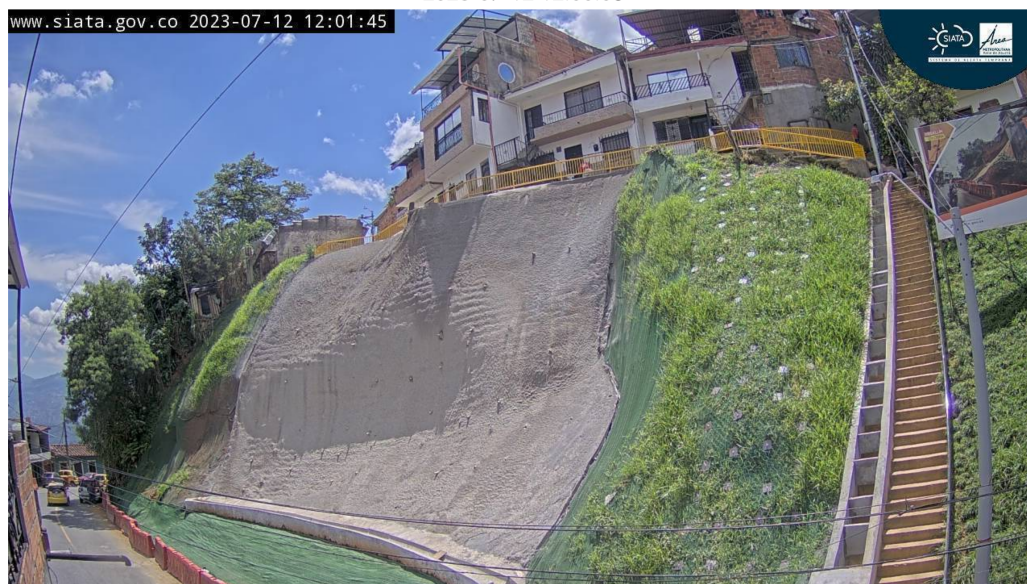
Figura 8: Fotografía registrada por la cámara de monitoreo el 12 de julio de 2023. Se observa la finalización de las obras de estabilización de la ladera afectada.
