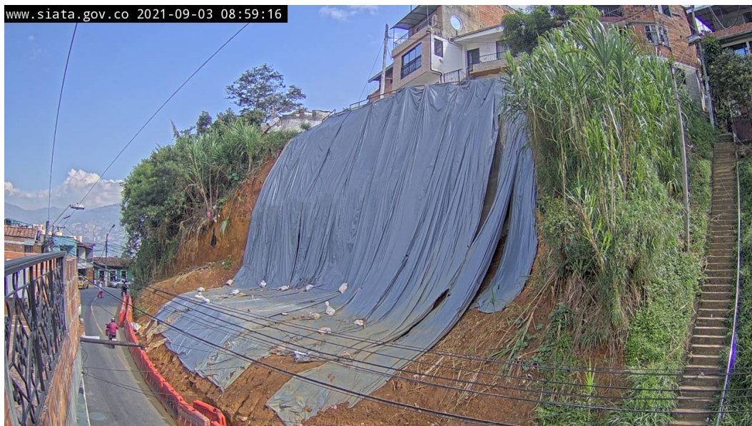
Figura 4: Fotografía registrada el 3 de septiembre de 2021. Se evidencia lona de plástico cubriendo el escarpe principal del movimiento en masa y acordonamiento del depósito para garantizar el flujo vehicular normal y evitar el ingreso de personas al sitio.
