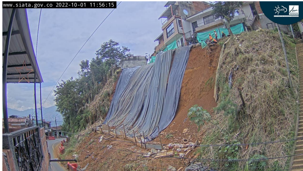
Figura 6: Fotografía registrada el 1 de octubre de 2022. Se observa el inicio de las obras de estabilización en el talud monitoreado.
