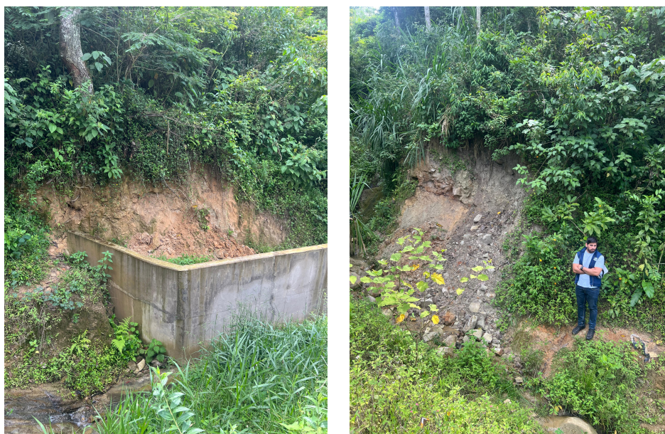
Figura 20: Fotografías tomadas el 18 de junio de 2024. Se evidencian procesos morfodinámicos en la desembocadura de la quebrada que desencadenó el flujo de lodos en el barrio Villalía. Estos procesos se asocian a la dinámica normal del drenaje, produciendo fenómenos de erosión lateral y desencadenando procesos superficiales en los flancos; favorecidos además por las características intrínsecas del material, la topografía y factores antrópicos. Por otro lado, no se evidencian acumulaciones de material sobre el cauce que obstruyan la circulación del agua al momento de la visita.
