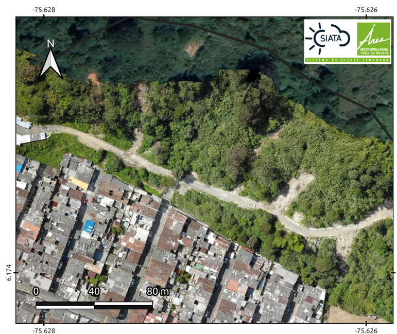
Figura 12: Ortofoto realizada al sitio el 12 de agosto de 2022. Se observa parcialmente la ladera norte del barrio Villalía y los procesos morfodinámicos materializados en junio de 2022
