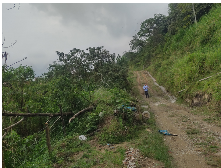
Figura 5: Material depositado en la vía vehicular. Fotografía tomada en marzo 10 de 2023, se removió el material de la vía vehicular.
