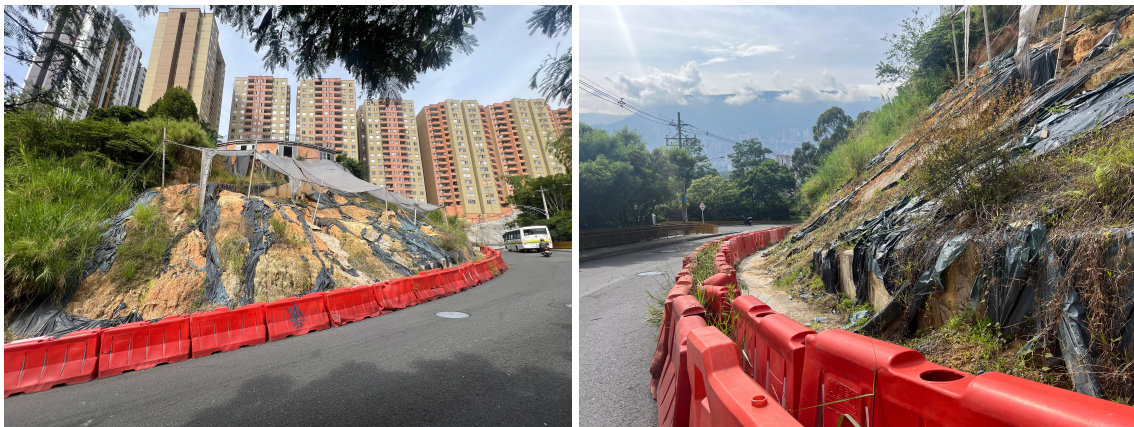
Figura 21: Fotografías tomadas el 18 de junio de 2024. Se evidencian procesos erosivos superficiales tipo surcos sobre el talud y deterioro del techo de lona de plástico, sin evidencia de nuevos desprendimientos de material en la zona de depósito del movimiento en masa.
