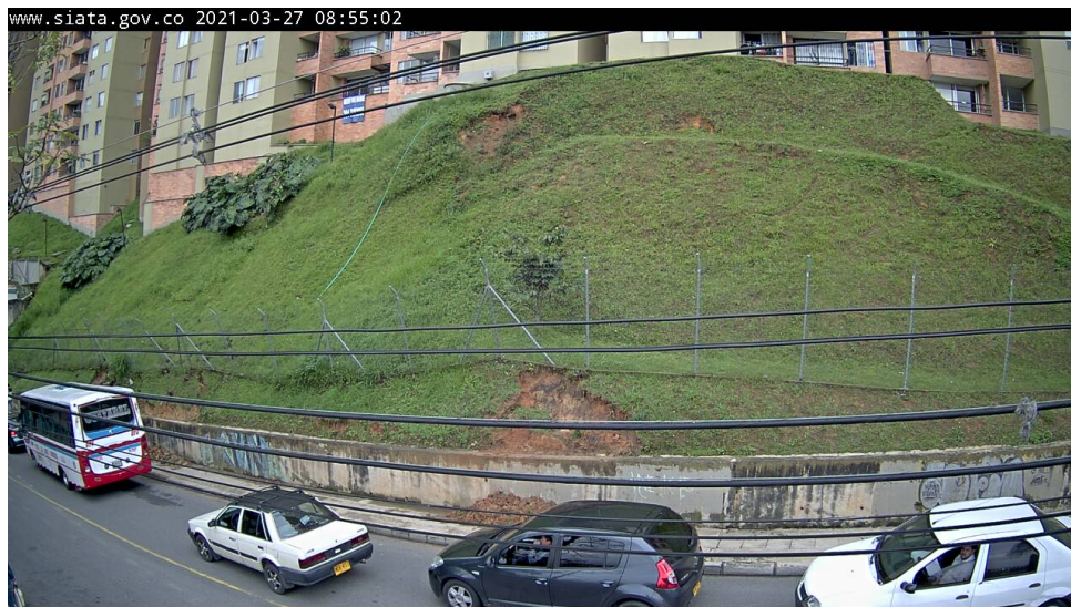
Figura 17: Fotografía de la cámara de monitoreo registrada el 27 de marzo de 2021. Al momento de la emergencia del “Deslizamiento 2”, se inició el monitoreo de esta zona del talud debido a las deformaciones superficiales, las cuales se han repetido durante el periodo de monitoreo, por lo cual, se realizó la instalación de coberturas de plástico.
