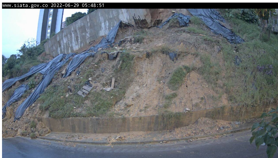
Figura 14: Fotografía de la cámara de monitoreo registrada el 29 de junio de 2022. Reactivación del deslizamiento y volcamiento de muro en concreto, el cual posteriormente es demolido y se habilita el tránsito por la vía Calle 9A Sur.
