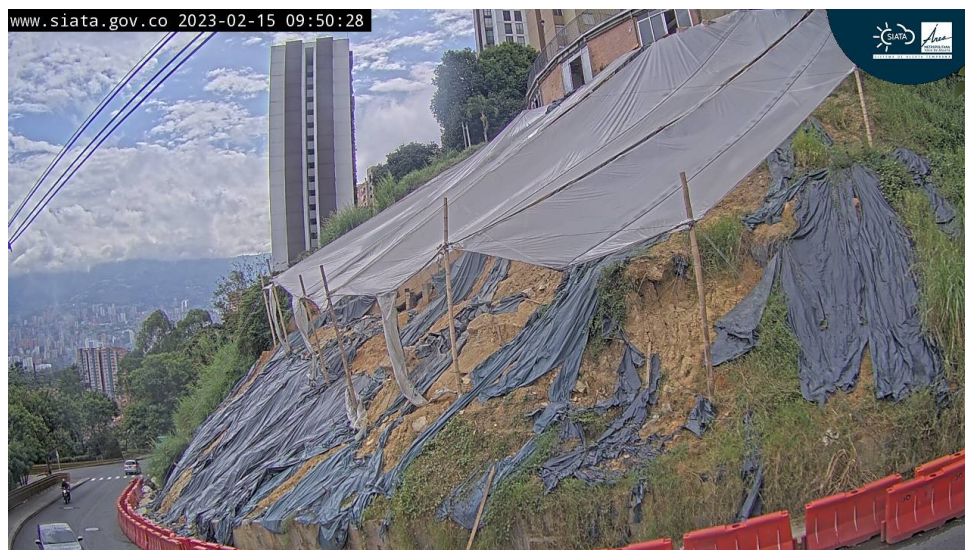
Figura 15: Fotografía de la cámara de monitoreo registrada el 15 de febrero de 2023. Talud cubierto con techo en plástico.
