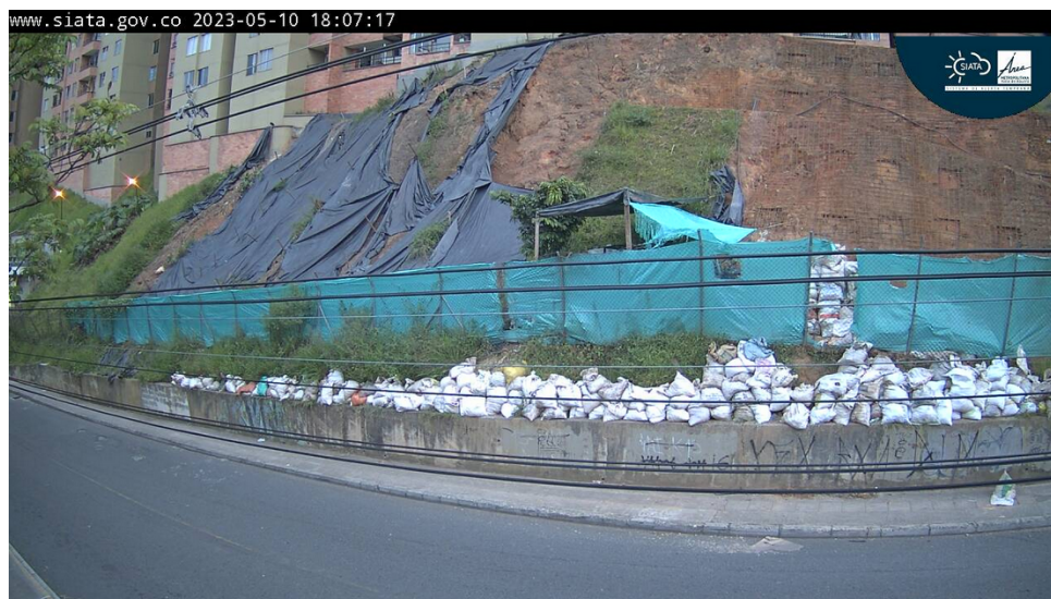
Figura 19: Fotografía de la cámara de monitoreo registrada el 10 de mayo de 2023. Nótese las obras de estabilización que se realizan al talud.
