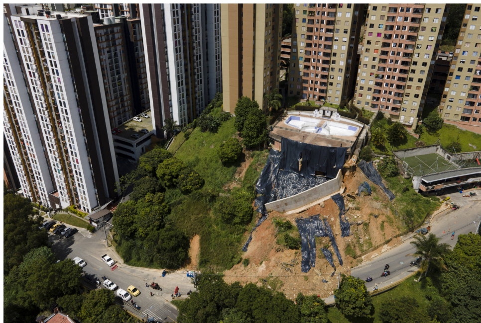
Figura 3: Fotografía del movimiento en masa reactivado en el talud de la Unidad Residencial Atavanza en junio de 2022.
