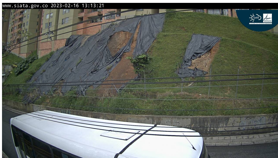
Figura 18: Fotografía de la cámara de monitoreo registrada el 2 de febrero de 2023. Las deformaciones de esta zona han sido cubiertas por lonas de plástico. Nótese el estado del cerramiento.
