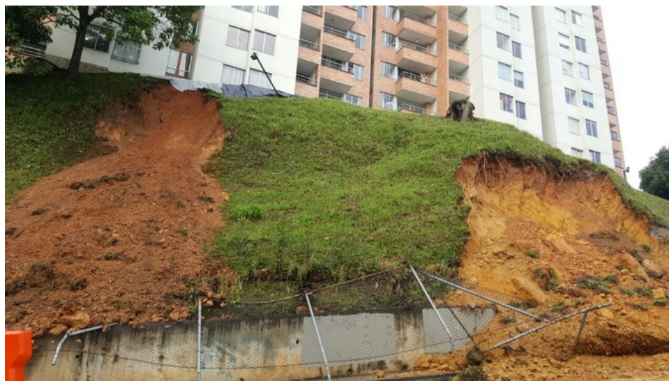
Figura 4: Fotografía del movimiento en masa (Deslizamiento 1) presentado en marzo de 2017 en otra sección del talud.
