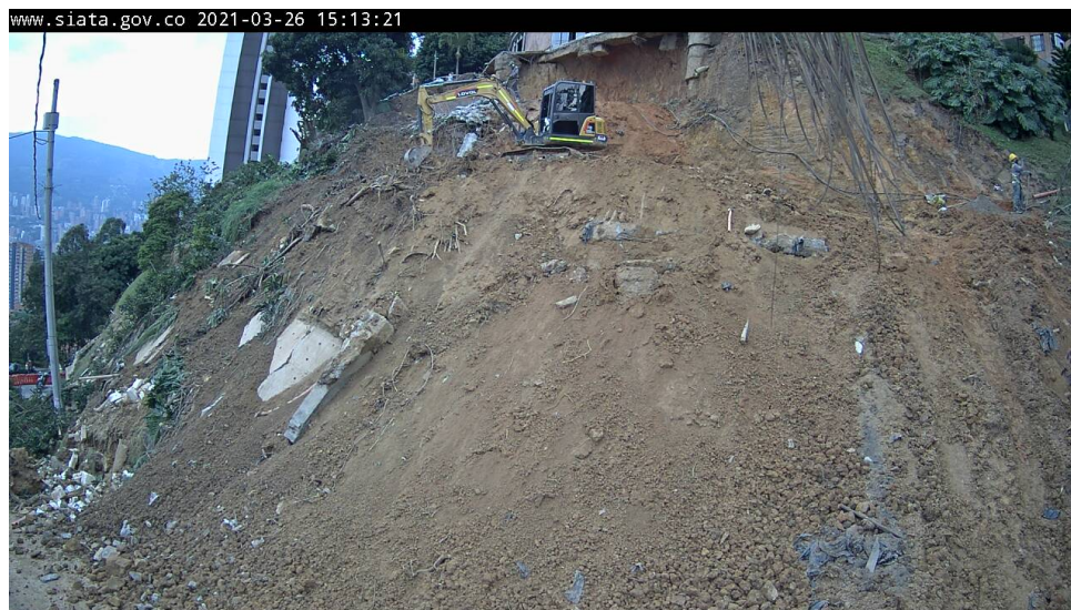
Figura 11: Fotografía de la cámara de monitoreo registrada el 26 de marzo de 2021. Se observan trabajos de remoción del material movilizado.
