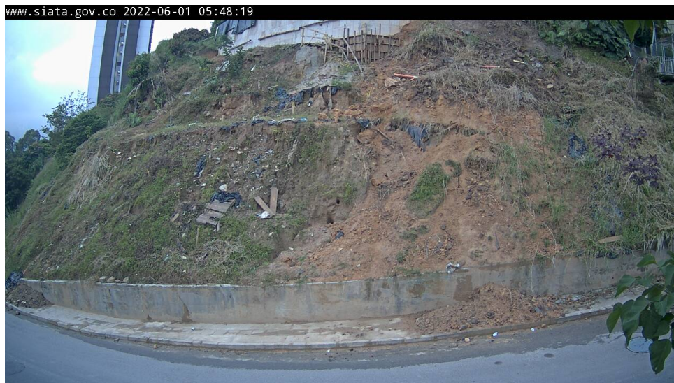
Figura 13: Fotografía de la cámara de monitoreo registrada el 1 de junio de 2022. Nótese la exposición del suelo, la escasa cobertura vegetal del talud y el deslizamiento superficial en la parte baja del talud.
