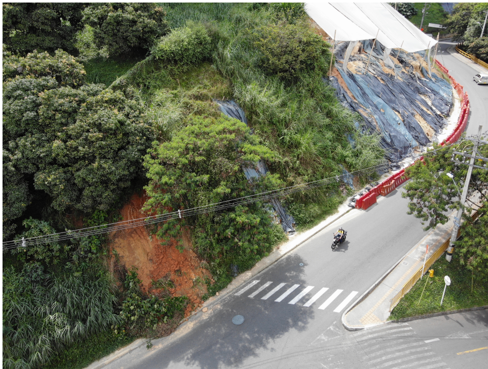
Figura 5: Fotografía tomada con drones al talud de la Unidad Residencial Atavanza en junio de 2022. Nótese los deslizamientos superficiales en otras zonas del talud.
