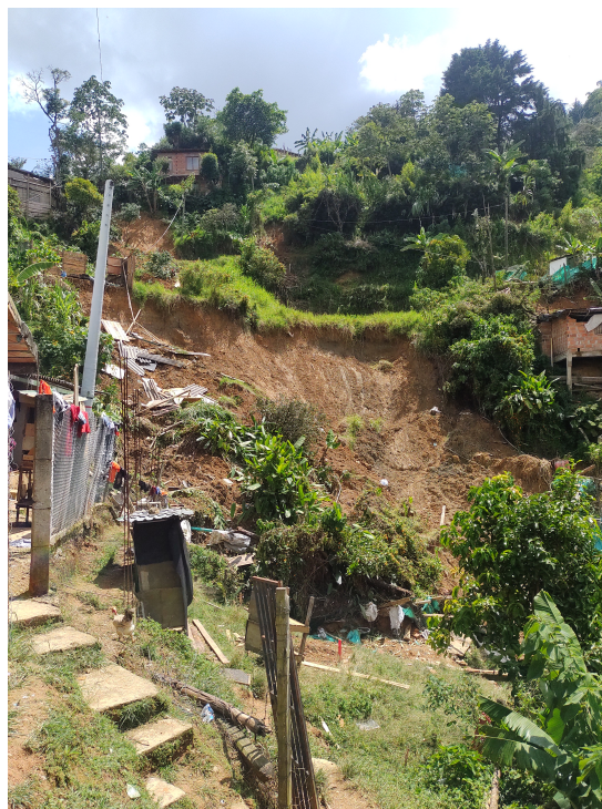
Figura 3: Deslizamiento rotacional en el centro del asentamiento Tierra Amarilla.
