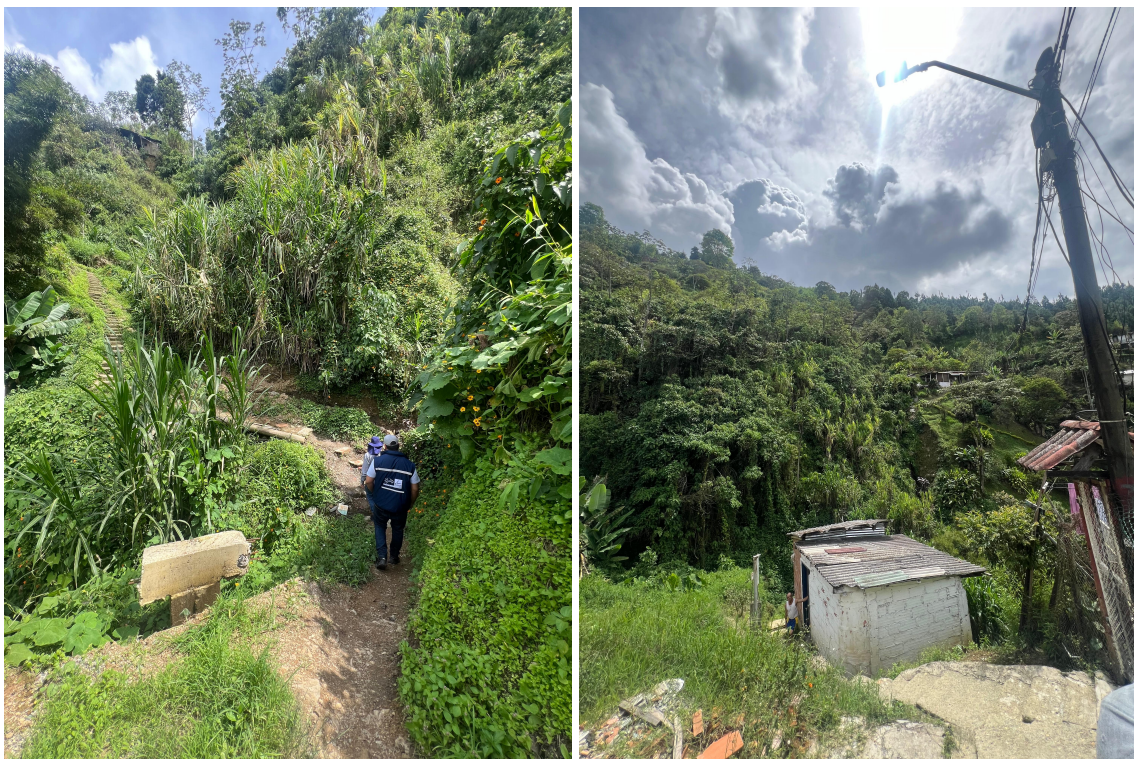
Figura 15: Fotografía registrada en visita de monitoreo el 18 de junio de 2024. Se evidenció recuperación parcial de la cobertura vegetal en la zona inicial de monitoreo, sin evidencia de nuevos desprendimientos de material recientes.
