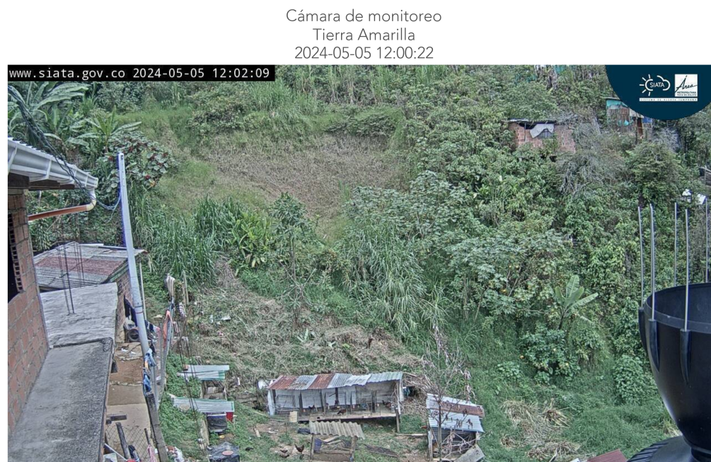
Figura 14: Fotografía de la cámara registrada el 5 de mayo de 2024. Se observa la recuperación de la cobertura vegetal en el escarpe principal del movimiento en masa. Se evidencian construcciones simples en el cuerpo del deslizamiento.
