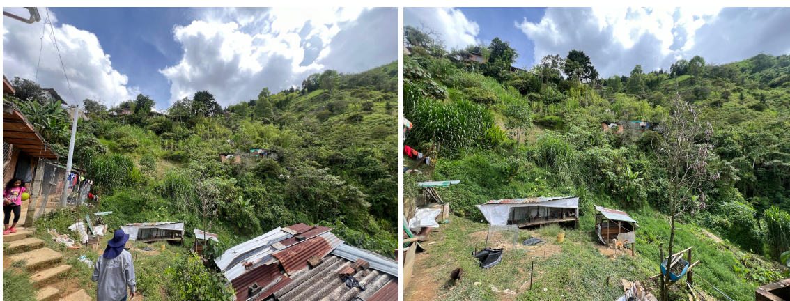
Figura 16: Fotografía registrada en visita de monitoreo el 18 de junio de 2024. Se evidenció la recuperación de la cobertura vegetal, sin evidencias de nuevos agrietamientos o reactivación del movimiento en masa.
