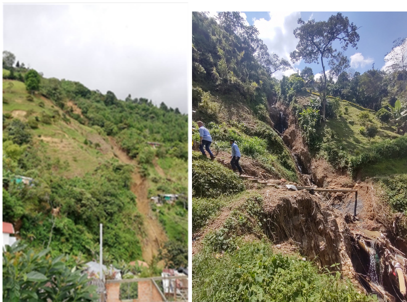
Figura 7: Fotografía izquierda tomada en noviembre de 2020, luego del evento de flujo torrencial. Fotografía derecha tomada en septiembre de 2022 luego de evento de creciente torrencial. Nótese el colapso del puente peatonal de acceso al asentamiento.
