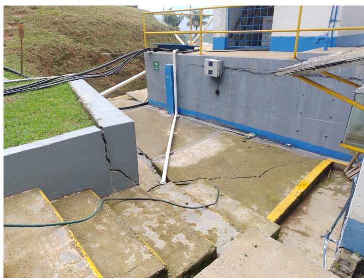
Figura 13: Lesiones en la estructura de la planta de acueducto veredal. Fotografía registrada en marzo de 2023.
