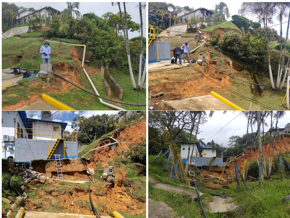
Figura 12: Evolución del escarpe principal en la zona de acceso a la planta de acueducto veredal. Imagen izquierda superior registrada en septiembre de 2021, imagen derecha superior registrada en marzo de 2022, imagen inferior izquierda registrada en septiembre de 2022, imagen inferior derecha registrada en marzo de 2023.
