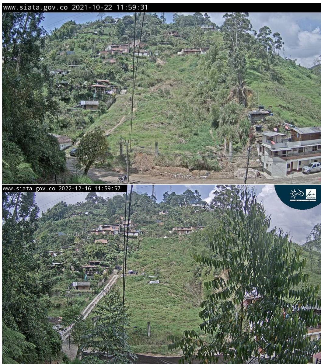
Figura 9: Fotografías de la cámara de monitoreo del deslizamiento. Fotografía superior registrada en octubre de 2021 y la fotografía inferior registrada en diciembre de 2022. No se observan deformaciones del relieve en la ladera; sin embargo, se observa caídas de árboles en la parte media de la ladera.
