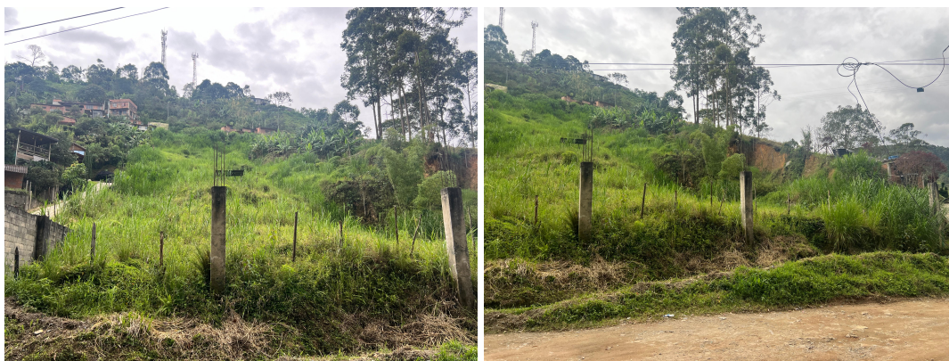
Figura 11: Fotografías registradas el 18 de junio de 2024. Se observa recuperación de la cobertura vegetal de pastos bajos. En la fotografía de la derecha se observa proceso erosivo formado un carcavamiento en uno de los flancos del deslizamiento.
