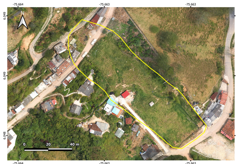
Figura 7: Ortomosaico de sobrevuelo de monitoreo realizado el 13 de marzo de 2024 sobre el deslizamiento Salinas. No se evidencian nuevos agrietamientos sobre la vía. Se observa colmatación por falta de mantenimiento en los canales hidráulicos y la construcción de una estructura en el costado suroccidental del deslizamiento.
