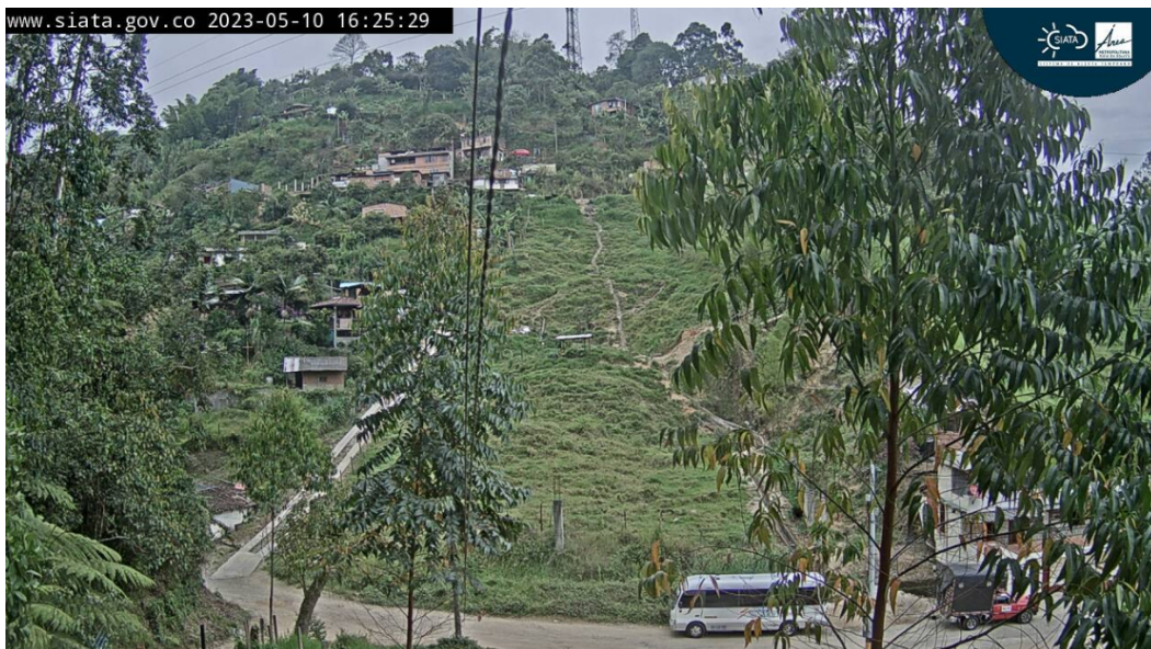
Figura 10: Fotografía de la cámara de monitoreo registrada el 10 de mayo de 2023. Se realizó una intervención al cuerpo del deslizamiento la última semana de abril; aparentemente, excavaciones asociadas a obras de drenaje.
