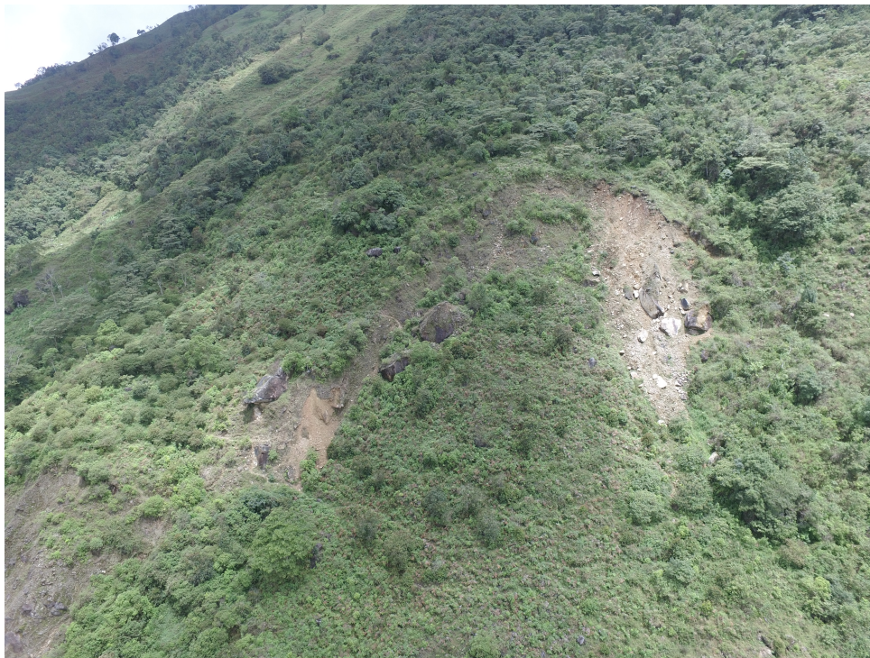
Figura 3: Fotografía panorámica de la corona del deslizamiento registrada en octubre de 2010. Se observan bloques de rocas de diámetro superior a un metro, las cuales podrían rodar ladera abajo.
