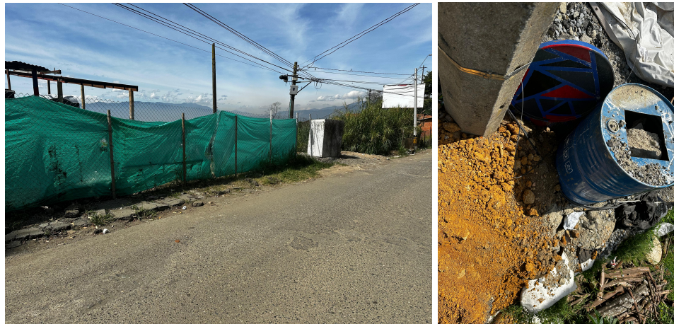
Figura 7: Fotografía registrada el 16 de julio de 2024. Se observa la construcción de malla eslabonada y se evidencian contenedores y material de escombros al rededor del poste donde están ubicados los sensores.
