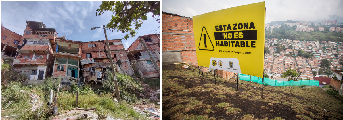
Figura 3: Figura izquierda, estado de estructuras de uso residencial afectadas por el movimiento en masa en el mes de octubre de 2021. Figura derecha, zona de afectación del deslizamiento en abril de 2022 en el lugar donde las edificaciones fueron desmontadas.
