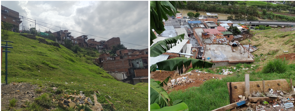
Figura 2: Figura izquierda, fotografía del talud monitoreado desde la parte baja del talud. Figura derecha, asentamiento humano ubicado en la parte baja del talud.
