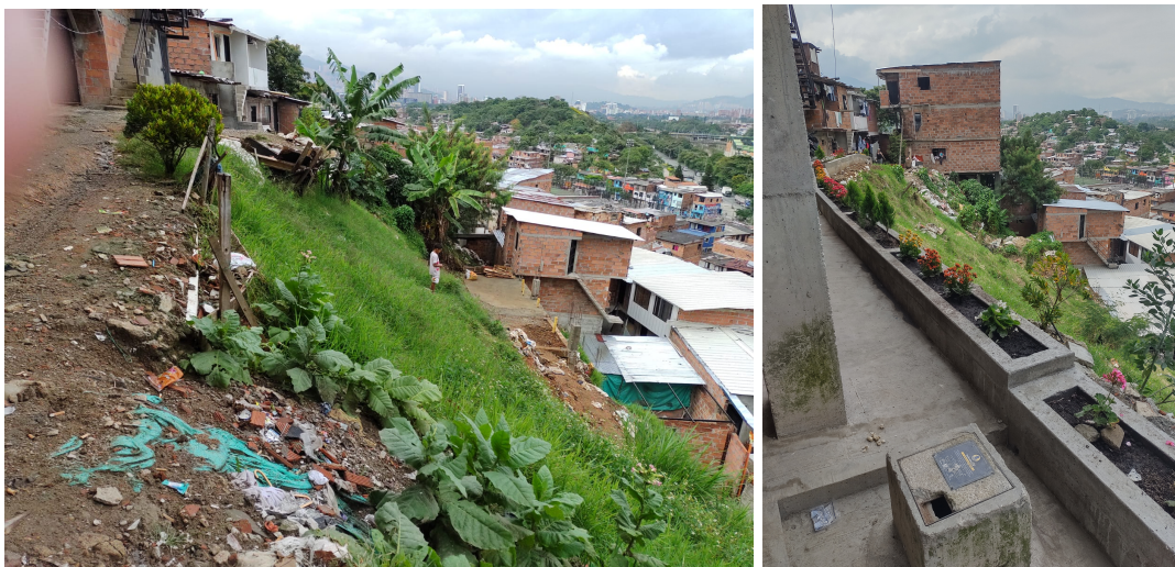
Figura 3: Figura izquierda, fotografía de agosto de 2021 de la parte alta del talud, lugar donde se observó un desprendimiento de suelo superficial asociado a las excavaciones realizadas por una construcción. Figura derecha, fotografía de la misma parte del talud en septiembre de 2022.
