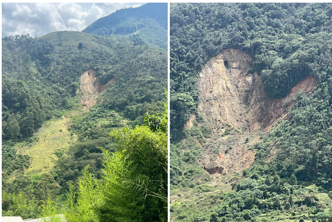
Figura 22: Fotografías de visita de monitoreo en sitio registradas el 18 de junio de 2024. Se observa leve recuperación vegetal en los flancos del escarpe del movimiento en masa y en la zona de tránsito.
